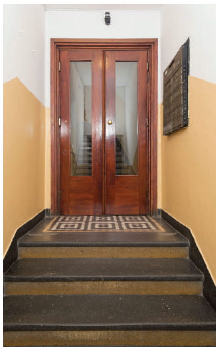
Strefa wejściowa w czynszowym domu wielorodzinnym przy ul. Słupeckiej 9, posadzka wykonana z lastryka, przed drzwiami kompozycja z gorsecików, na ścianie historyczna skrzynka na listy.
