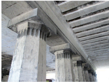
Żelbetowe kolumny wiaduktu alei Piłsudskiego z dekoracją w stylu art deco, wykonaną w betonie.
