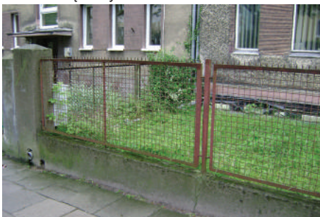
Ogrodzenie z metalowej siatki w ramach mocowanych do murowanych słupków, charakterystyczne dla lat 30. XX w.
