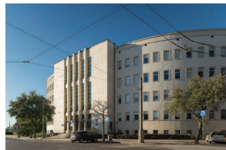
Budynek Sądu Rejonowego przy pl. Konstytucji 5, płyty kamienne ułożono na najważniejszych częściach elewacji, w tym na ryzalicie części wejściowej i cokołach.
