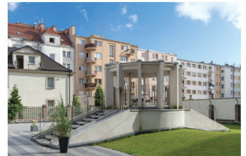
Żelbetowa wiata-altana na podwórzu budynku przy ul. 3 Maja 27-31, doświetlająca i wentylująca garaż podziemny, unikatowa w skali ogólnopolskiej, która nie została wykończona z uwagi na wybuch wojny i została dopiero odrestaurowana i wykończona w 2015 r. ze środków gminy.
