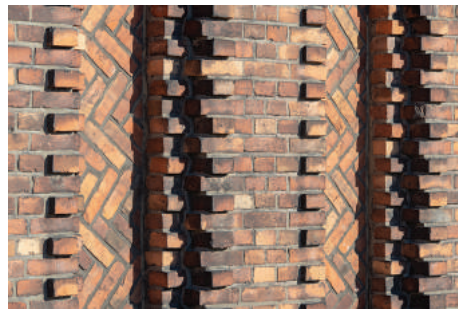
Detale ceglane na elewacji Chłodni portowej przy ul. Polskiej 20.
