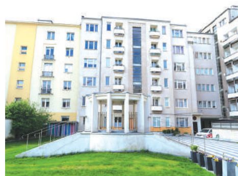
Żelbetowa, naziemna wiata garażu podziemnego, mieszcząca doświetlenie i wentylację wnętrza, w budynku przy ul. 3 Maja 27-31
