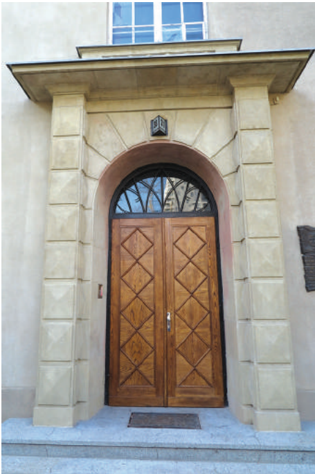
Portal budynku Biura Budowy Portu przy ul. Waszyngtona 38 z lat 20. XX w., wykonany z masywnych bloków kamiennych z piaskowca, po konserwacji.
