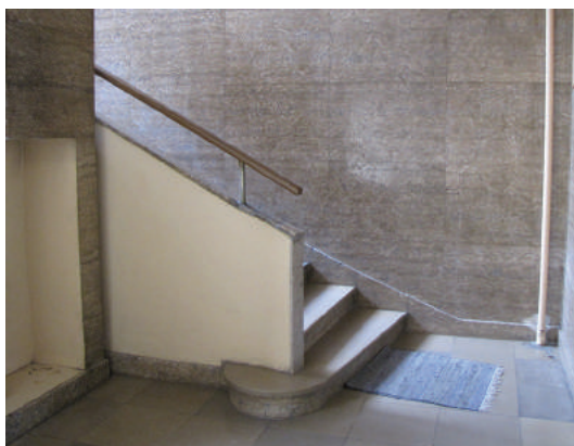
↑ Fragment strefy wejściowej w kamienicy przy ul. Bema 15, dolne partie ścian oraz posadzka wykonana z lastryka o intensywnych kolorach.
