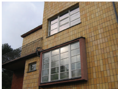
↑3. Willa przy ul. Inżynierskiej 111, lata 30. XX w. Okna modernistyczne o obrysie poziomych prostokątów, poddane w 2007 r. pracom konserwatorskim. Okno dolne jest charakterystyczne dla awangardowych budynków modernistycznych, bo dzięki konstrukcji z żelbetowej ramy wysuniętej przed lico elewacji, uzyskano znaczny dystans pomiędzy zewnętrzną, a wewnętrzną płaszczyzną przeszklenia, tworząc szeroki parapet, który mógł być małą oranżerią.
