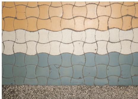
Posadzka z tzw. gorsecików w strefie wejściowej w budynku na Kamiennej Górze, detal
