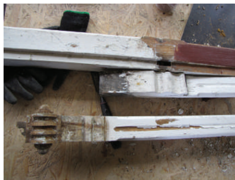
4, 5, 6. Dekoracyjny detal okien d. Zajazdu Adlera przy ul. Orłowskiej 8 w trakcie prac konserwatorskich. Prace konserwatorskie polegały m.in. na usunięciu powłok malarskich poprzez podgrzewanie i zdejmowanie szpachelką grubych warstw farby, następnie uzupełnianie ubytków w drewnie, elementy były szlifowane, malowane i ponownie szklone. Część zniszczonych elementów trzeba było zrekonstruować, ale okna pochodzą z XIX w. Prace wykonano w ramach kompleksowej rewaloryzacji budynku trwającej w latach 2011-2013.
