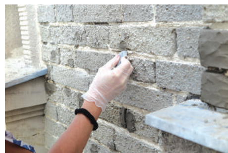
Przygotowanie masy cementowo-piaskowej i uzupełnianie ubytków cegieł na elewacji Uniwersytetu Morskiego.
