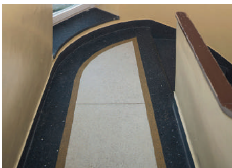
Trzykolorowa posadzka na podeście schodowym w budynku przy ul. Słupeckiej 9
