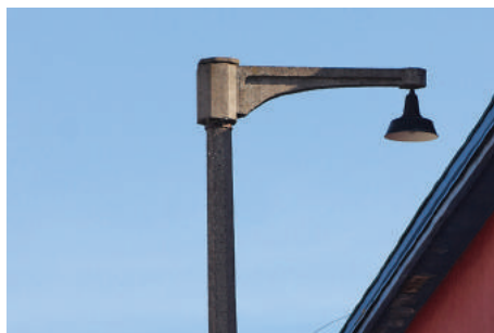
Żelbetowa latarnia uliczna z lat 30. XX w.
