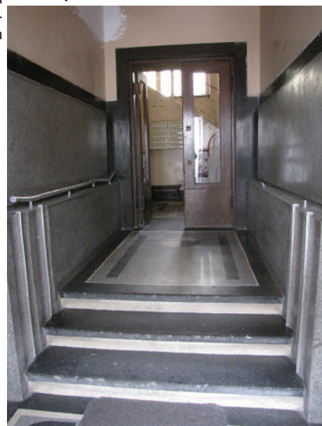
Strefa wejściowa w kamienicy przy ul. Świętojańskiej 122, dolne partie ścian oraz posadzka wykonana z lastryka, po obu stronach także dekoracyjne, aluminiowe poręcze.
