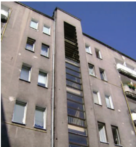
↑→Uchylne okna klatek schodowych w budynku przy ul. 3 Maja 27-31 (Śródmieście).
