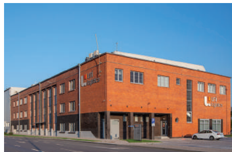
Budynek firmy "Bananas" przy ul. Polskiej 21.
