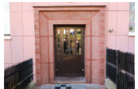
Portal budynku przy ul. Krasickiego 42 z lat 30. XX w., wykończony tynkiem szlacheckim, po odrestaurowaniu staraniem mieszkańców budynku.
