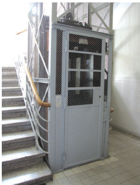
Winda w kamienicy przy ul. Świętojańskiej 53, wejście
