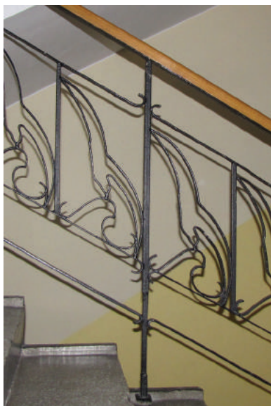
Metalowa balustrada o indywidualnym motywie mew i morskich fal we wnętrzu powojennego budynku Akademii Marynarki Wojennej przy ul. Śmidowicza 69
