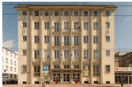
↑Bank Gospodarstwa Krajowego przy ul. 10 Lutego 10, masywne lizeny wykonane z bloków żółtoszarego wapienia, pozostałe partie elewacji wykończone tynkiem.
