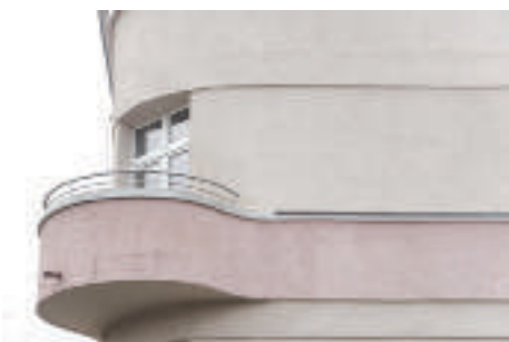
Budynek z lat 30. XX w. przy ul. Piotra Skargi 9, detal balkonu.
