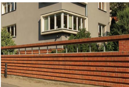
Ceglane, dekoracyjne ogrodzenie willi na Kamiennej Górze z lat 30. XX w., dostosowane materiałem i połączone z ceglana częśćią elewacji.
