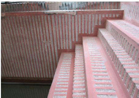
Portal kamienicy przy ul. Bema wykończony tynkami kamieniarskimi w trakcie prac konserwatorskich.
