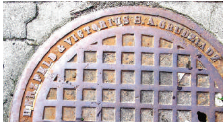
Żeliwna pokrywa studzienki kanalizacyjnej z firmy „Herzfeld i Victorius” z Grudziądza, występująca w wielu miejscach miasta.
