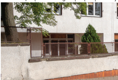
Ogrodzenie z uskokami willi hr. Łosiowej na Kamiennej Górze z lat 30. XX w., murowane i otynkowane oraz uzupełnione przesłami z metalowej siatki w ramach, tworzące pasmo podkreślające architekturę budynku.
