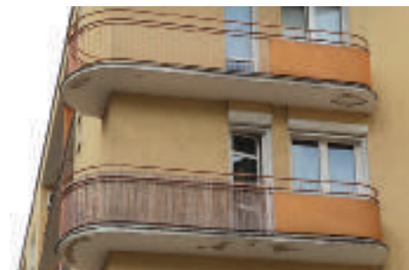
Budynek z lat 50. XX w. przy ul. 3 Maja 18, półokrągłe balkony ażurowe, z pełnymi wypełnieniami.
