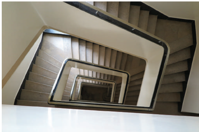
Dusza klatki schodowej w kamienicy przy ul. Świętojańskiej 44.
