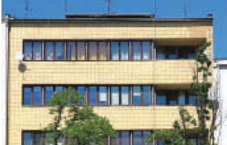
Kamienica z 2. połowy lat 30. XX w. przy Skwerze Kościuszki 16, loggie podkreślające rytm i plastykę elewacji.
