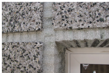
Elewacja frontowa kamienicy przy ul. Świętojańskiej 105 z tynkiem tworzącym prostokątne pola rozdzielone wąskimi, wgłębionymi rowkami, co ułatwiało wykonawstwo. Zdjęcie poniżej ukazuje szczegół tynku z widocznymi grubymi ziarnami.
