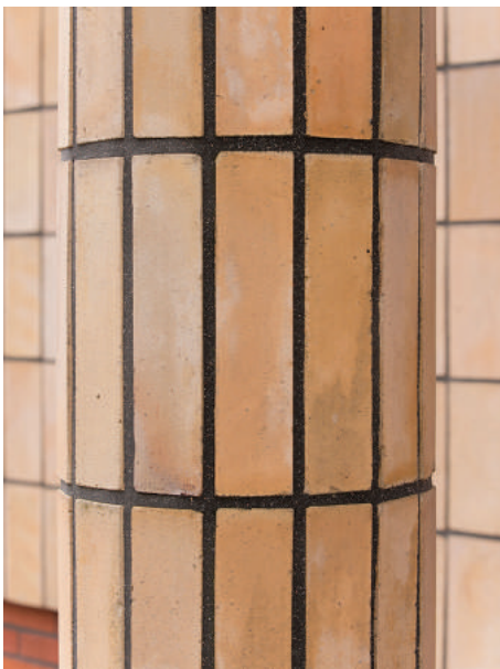
Detal elewacji willi w Orłowie, węższymi płytkami oblicowano okrągłe słupy strefy wejściowej, widoczne czarne spoiny z drobnym białym kruzywem.
