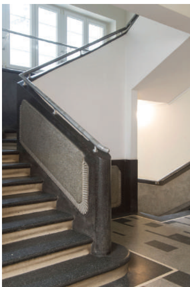
Balustrada murowana zwieńczona metalową poręczą. Klatka schodowa w kamienicy przy ul. Abrahama 28
