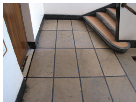
Posadzka w budynku przy ul. 3 Maja 27-31. Płyty beżowe z wapienia Morawica oddzielone czarnymi pasmami z wapienia Dębnik.
