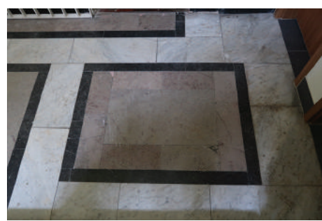
Posadzka kamienna w budynku d. Banku Gospodarstwa Krajowego przy ul. 10 Lutego 8.
