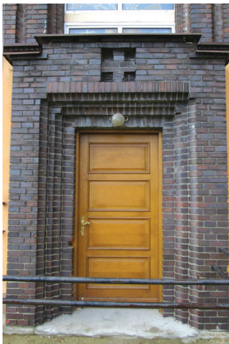
Portal kościoła garnizonowego na Oksywiu z lat 30. XX w., dekorowany ceglami klinkierowymi o specjalnych kształtach.
