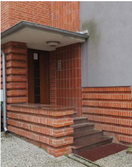
Wejście do willi modernistycznej na Kamiennej Górze z ceglany wykończeniem i żelbetowym daszkiem osłaniającym podest.
