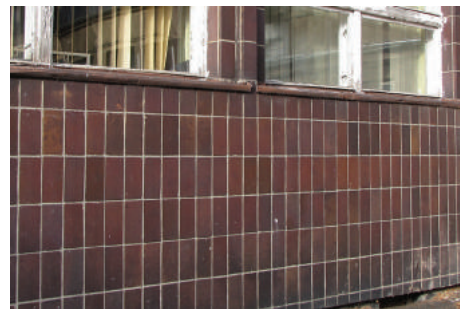
Fragment cokołu budynku na Grabówku oblicowany brązowymi płytkami z jasnymi spoinami.
