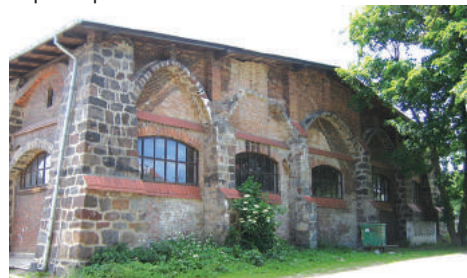
Stajnia w zespole dworko-parkowym Kolibki z masywnymi filarami konstrukcyjnymi wykonanymi z ociosanych kamieni narzutowych
