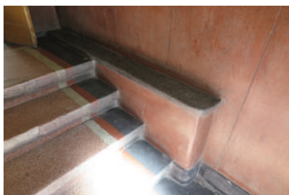
↑ Fragment strefy wejściowej w kamienicy przy ul. Bema 15, dolne partie ścian oraz posadzka wykonana z lastryka o intensywnych kolorach.
