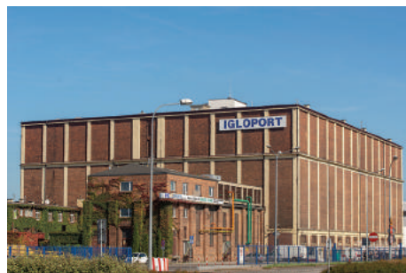
Chłodnia portowa przy ul. Polskiej 20 z konstrukcją żelbetową i elewacjami wykończonymi ceglami.
