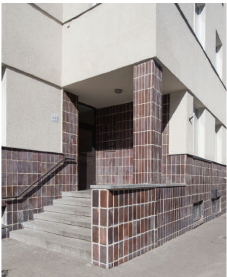
Strefa wejścia do budynku mieszkalnego ZUS przy ul. 3 Maja 22-24, brązowymi płytkami oblicowano ściany w podcieniu i cokół.
