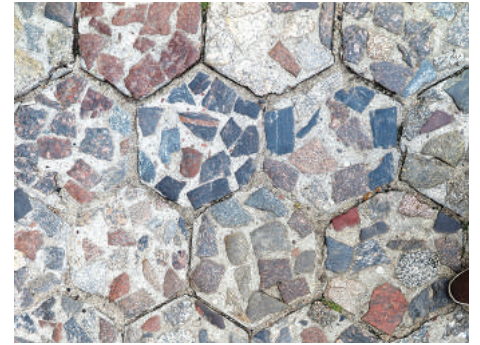
Betonowa kostka sześciokątna tzw. trylińska (od nazwiska Tryliński), z powierzchnią wyłożoną naturalnymi kamieniami, stosowana w latach 30. XX w. i po wojnie.
