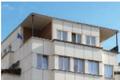
Budynek z końca lat 30. XX w. przy ul. 3 Maja 27-31, narożnikowe loggie od strony ul. Batorego.
