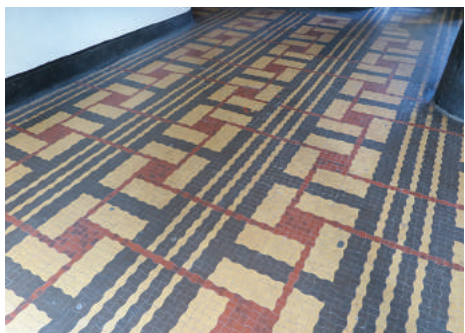
Posadzka w przejściu bramnym budynku przy ul. 3 Maja 27-31, jedna z najbardziej efektownych posadzek z gorsecików zachowana w Gdyni
