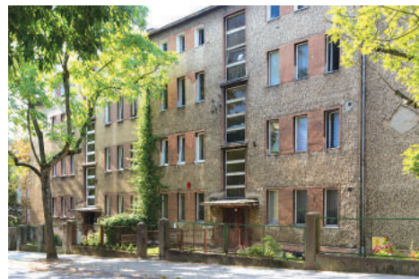
Modernistyczna elewacja budynku przy ul. Kraśnickiego 36-38, lata 30. XX w., zestawienie tynków szlachetnych o różnych barwach i sposobie opracowania
