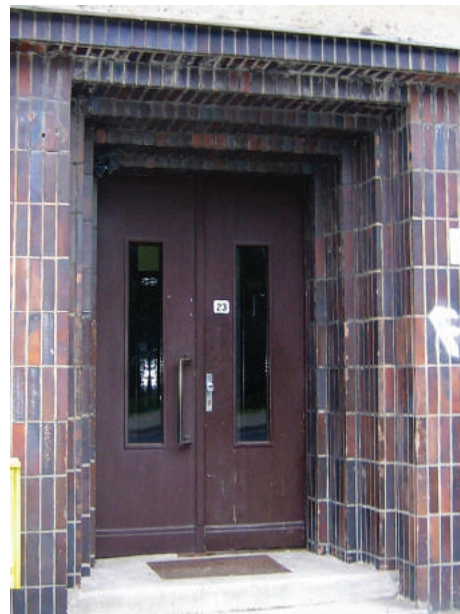
Portal części mieszkalnej budynku przy ul. Legionów, brązowymi płytkami oblicowano również elewację pawilonu sklepowego.
