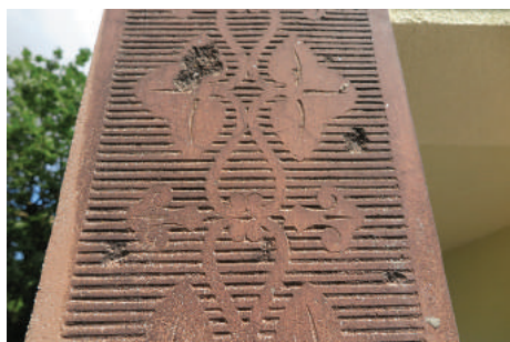
Dekoracja z motywem roślinnym na prążkowanym tle, wykuta na słupie podcienia budynku w Działkach Leśnych.
