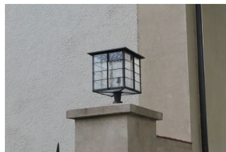
Lampa z końca lat 20. XX w. przed wejściem do budynku d. Biura Budowy Portu przy ul. Waszyngtona 38
