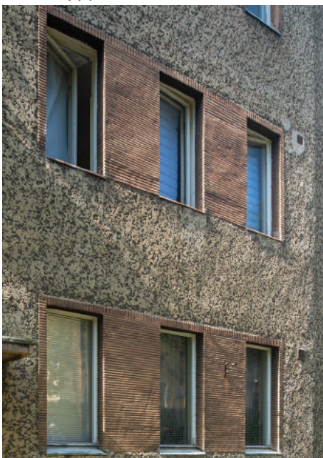
Budynek przy ul. Krasickiego z lat 30. XX w., który ma na elewacji dwa rodzaje tynków dekoracyjnych – szary i czerwony.
