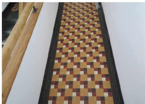
Posadzka na podestach klatki schodowej w budynku na Wzgórze Św. Maksymiliana
