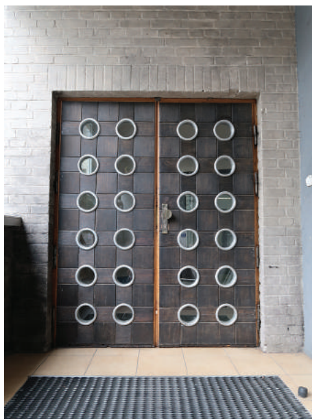
Drzwi głównego wejścia do siedziby Stowarzyszenia YMCA Gdynia przy ul. Żeromskiego 28, z okładziną z czarnego dębu i aluminiowymi oprawami okrągłych przeszkleń.
