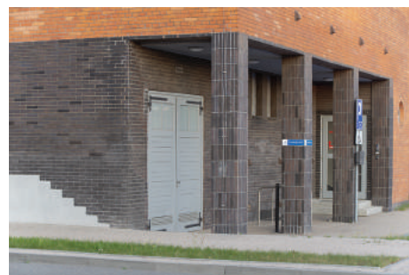
Elewacja budynku firmy „Bananas” przy ul. Polskiej 21, brązowe płytki ceramiczne zastosowano w strefach wejściowych, zestawiając je z czerwonymi ceglami licowymi.
