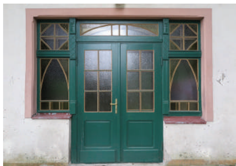
Drzwi do dworu Nowe Obluże przy ul. Rybaków z początku XX w. ze zrekonstruowanym układem podziałów i odtworzeniem oryginalnego zielonego koloru.
