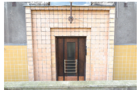
Portal od podwórza budynku przy ul. 3 Maja 27-31 z lat 30. XX w., obłożony płytkami ceramicznymi.
