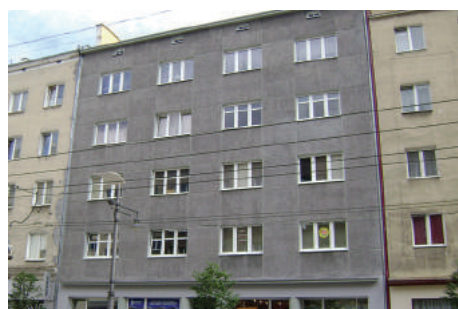
Elewacja frontowa kamienicy przy ul. Świętojańskiej 105 z tynkiem tworzącym prostokątne pola rozdzielone wąskimi, wgłębionymi rowkami, co ułatwiało wykonawstwo. Zdjęcie poniżej ukazuje szczegół tynku z widocznymi grubymi ziarnami.
