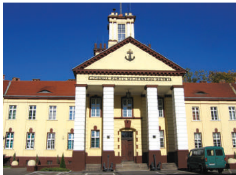
Część wejściowa do gmachu dawnego Dowództwa Floty z lat 20. XX w. na Oksywiu.
