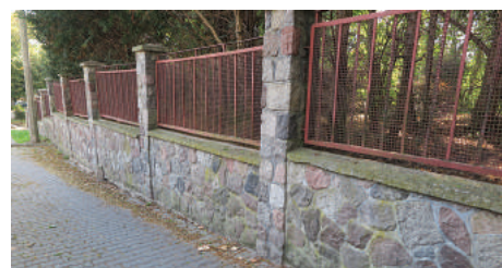
Ogrodzenie z masywnym cokołem i słupkami wymurowane z kamieni narzutowych i ażurowymi przesłami z metalowej siatki w ramach
