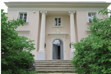
Część wejściowa do willi „Sokola” na Kamiennej Górze z lat 20. XX w. z wnęką i dwiema kolumnami.
