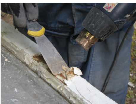
4, 5, 6. Dekoracyjny detal okien d. Zajazdu Adlera przy ul. Orłowskiej 8 w trakcie prac konserwatorskich. Prace konserwatorskie polegały m.in. na usunięciu powłok malarskich poprzez podgrzewanie i zdejmowanie szpachelką grubych warstw farby, następnie uzupełnianie ubytków w drewnie, elementy były szlifowane, malowane i ponownie szklone. Część zniszczonych elementów trzeba było zrekonstruować, ale okna pochodzą z XIX w. Prace wykonano w ramach kompleksowej rewaloryzacji budynku trwającej w latach 2011-2013.
