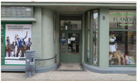
Wejście do kamienicy przy ul. Świętojańskiej 89 – charakterystyczne rozwiązanie modernistyczne z umieszczeniem drzwi we wnęce pomiędzy witrynami.
