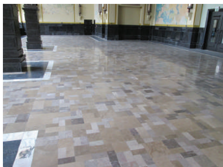
Posadzka w budynku dworca kolejowego Gdynia Główna przy pl. Konstytucji 1. Mozaika z płytek z wapieni Dębnik, Morawica i Bolechowice oraz biało-różowego marmuru Marianna.
