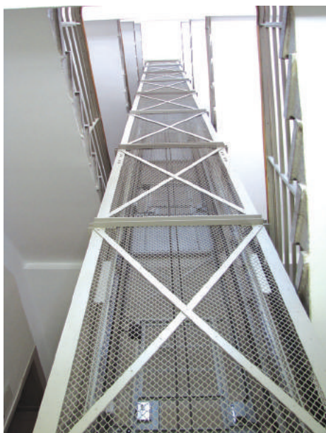
Winda w kamienicy przy ul. Świętojańskiej 53, ażurowy szymb w duszy schodów
