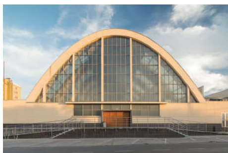
Hala targowa z lat 30. XX w. z łukami o stalowej konstrukcji, na których wykonano żółte tynki imitujące okładzinę z płyt kamiennych z piaskowca.
