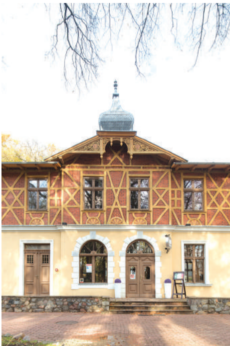
Elewacja d. Zajazdu Adlera (ob. Liceum Sztuk Plastycznych), przy ul. Orłowskiej 8, przełom XIX i XX w., parter murowany, piętro w konstrukcji ryglowej z ozdobnym zwieńczeniem szczytu ryzalitu
