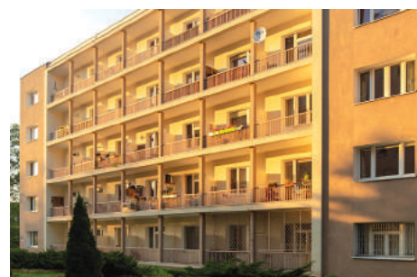
Budynek z końca lat 30. XX w. przy ul. Partyzantów 39, loggie na elewacji południowej.
