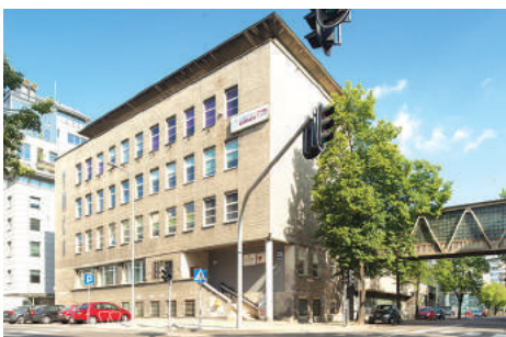
Budynek YMCA przy ul. Żeromskiego 26, pocz. lat 50. XX w., elewacja wykończona szarymi ceglami cementowymi
