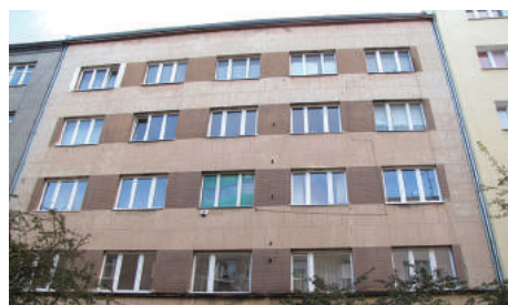
Elewacja frontowa kamienicy przy ul. Starowiejskiej 23 z dwoma rodzajami tynku – gładkim jasnym na płaszczyźnie i ciemnym rowkowanym pomiędzy oknami.
