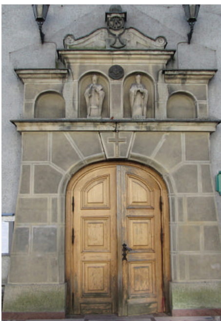
Portal kościoła pw. Najświętszej Marii Panny od ul. Świętojańskiej, wykończony szlachetnym tynkiem imitującym bloki kamienia.
