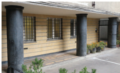
Wykończenie tynkarskie podcienia przy ul. 3 Maja 27-31 z tynkami szlifowanymi imitującymi kamień – żółtym na ścianie i czarnym na kolumnach. Jeden z najlepszych w Gdyni przykładów rzemiosła budowlanego z lat 30. XX w. Poniżej detal.
