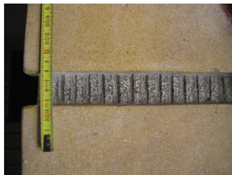
Fragment wykończenia tynkarskiego ściany podcienia budynku przy ul. 3 Maja 27-31 z pasami żółtego szlifowanego tynku rozdzielonego rowkami, w których wykonano tynk w kolorze grafitowym z białymi kamykami dodatkowo ponacinany pionowo.
