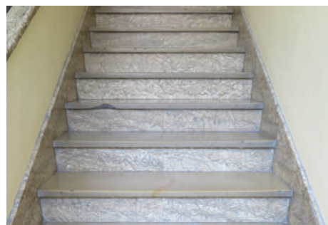
Posadzka na klatce schodowej w budynku przy ul. Abrahama 37. Płyty z wapienia mikrytowego, podstopnice i cokoły schodów z okładziny marmurowej, prawdopodobnie importowanej.
