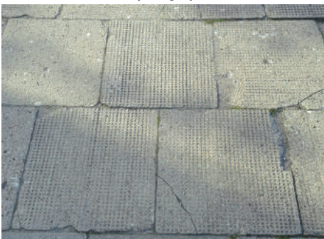
Nawierzchnia chodnika z płyt betonowych o wymiarach 50x50 cm z charakterystycznymi wgłębieniami stosowanymi w latach 30. XX w.
