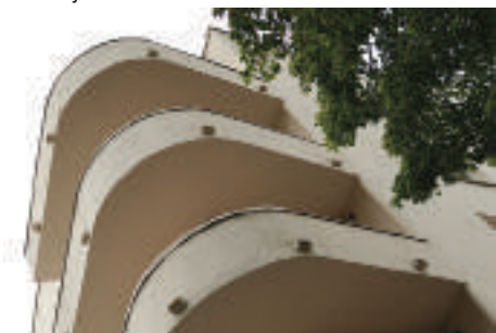
Budynek z lat 50. XX w. przy ul. Pułaskiego 3-5/Żeromskiego 41-43, zaokrąglone balkony od strony ul. Pułaskiego.
