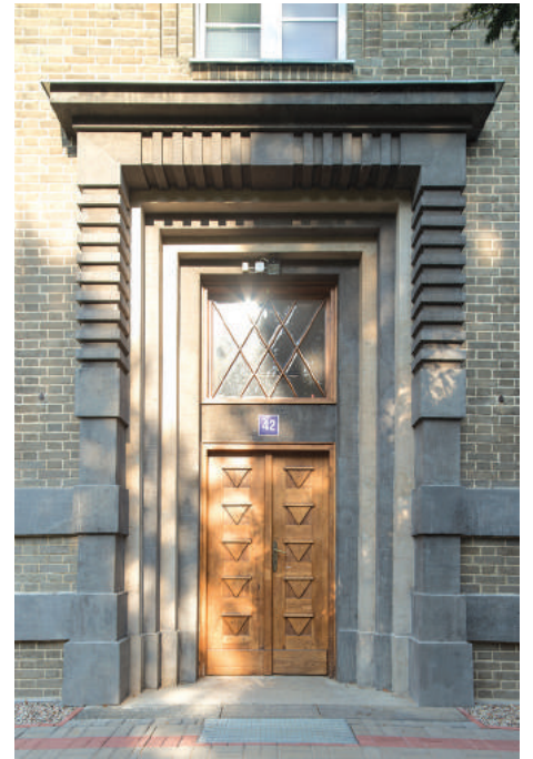
Portal budynku administracyjnego Uniwersytetu Morskiego przy ul. Morskiej 81-87 z końca lat 20. XX w., dekorowany tynkami szlacheckimi w dwóch kolorach.
