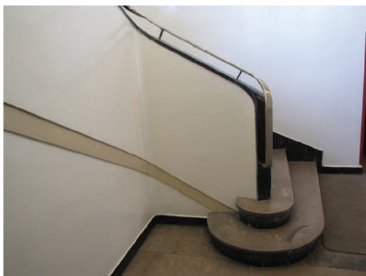
Dusza klatki schodowej w kamienicy przy ul. 10 Lutego 32. Widoczny układ serpentyny podkreślony ażurowymi, metalowymi balustradami z poręczą z drewna.
