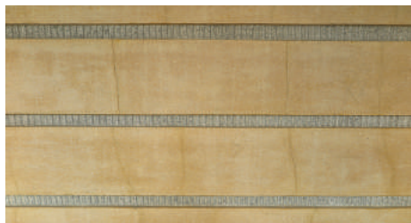
Wykończenie tynkarskie podcienia przy ul. 3 Maja 27-31 z tynkami szlifowanymi imitującymi kamień – żółtym na ścianie i czarnym na kolumnach. Jeden z najlepszych w Gdyni przykładów rzemiosła budowlanego z lat 30. XX w. Poniżej detal.
