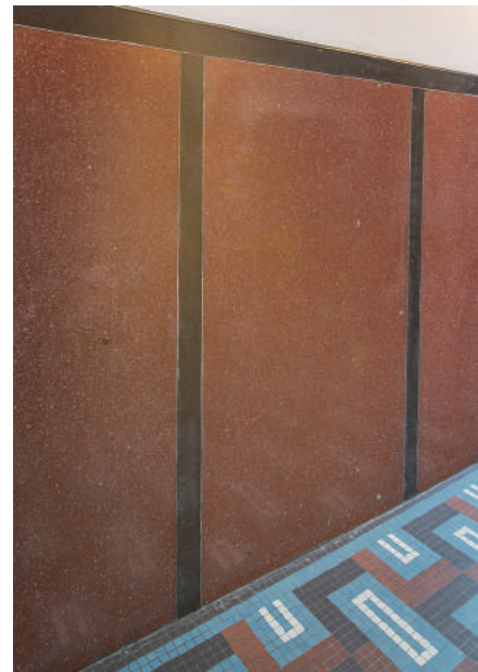
Fragment strefy wejściowej w kamienicy przy ul. 10 Lutego 5, w dolnej partii ścian dwukolorowe lastryko, posadzka utworzona z barwnych płytek tzw. irysków.
