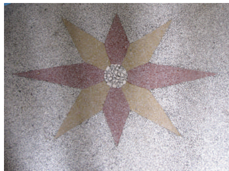
Motyw dekoracyjny z lastryka w budynku przy ul. Mickiewicza 33
