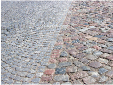
Dwa rodzaje nawierzchni brukowej z regularnej kostki i zgrubnie obrobionych kamieni.
