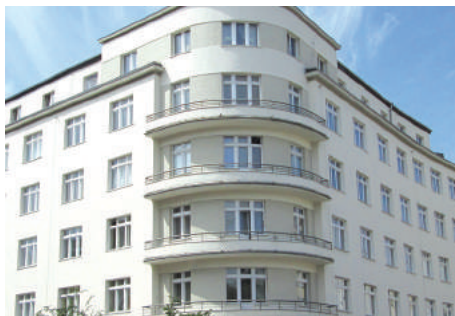
Kamienica Hundsdorffa z lat 30. XX w. przy ul. Starowiejskiej 7/Abrahama 2., balkony podkreślają swoim kształtem zaokrąglenie narożnika.
