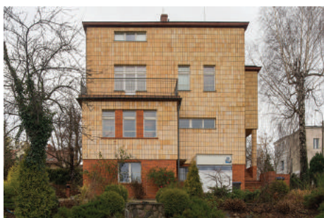
Elewacja willi w Orłowie oblicowanej żółtymi płytkami ceramicznymi kontrastowanymi z ciemnymi spoinami, elewację w latach 2007-2008 poddano pracom konserwatorskim.
