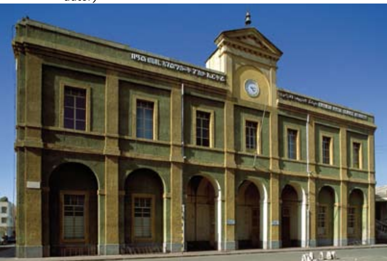
2. Poczta Główna (1916), architekt Odoardo Cavagnari (fot. autor)
