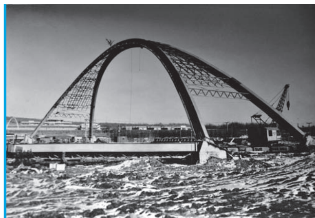
5. Hala Kwiatów w Chorzowie, wznoszenie konstrukcji w 1967 r. (fot. z archiwum Jerzego Gottfrieda)
