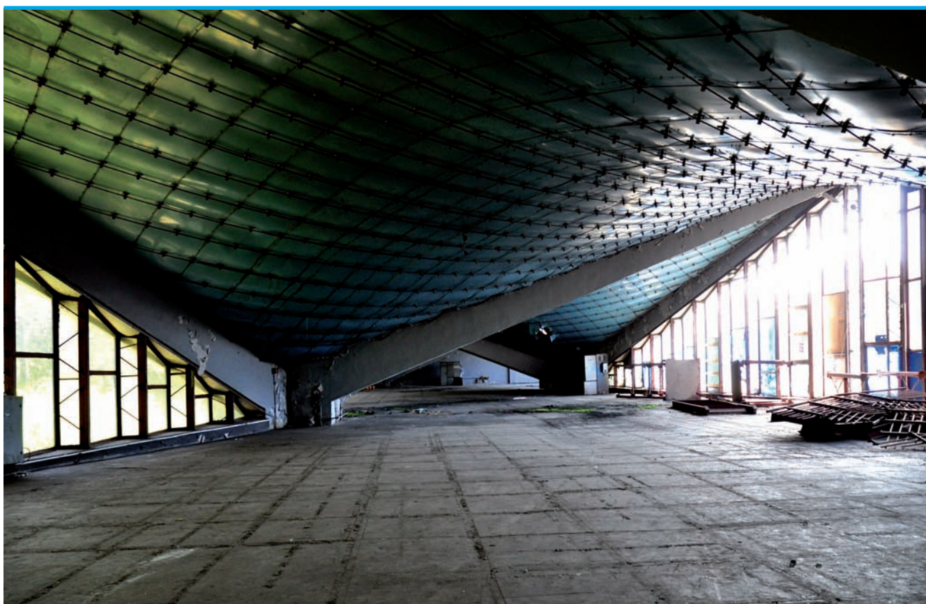
3. Pawilon „CG” w Chorzowie, arch. Jerzy Gottfried, 1962 r., wewnątrz (fot. A. Syska, 2014 r.)
