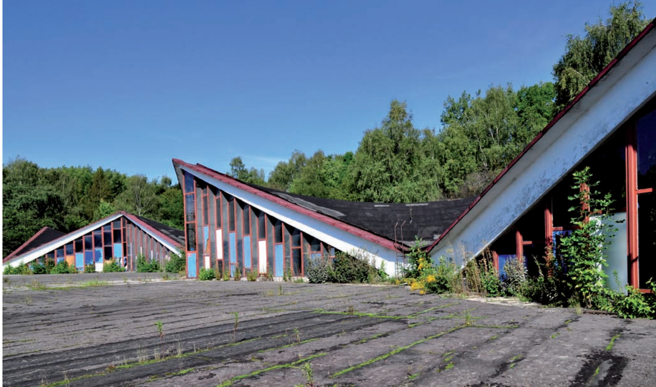
2. Pawilon „CG” w Chorzowie, arch. Jerzy Gottfried, 1962 r., widok od południa (fot. A. Syska, 2014 r.)
