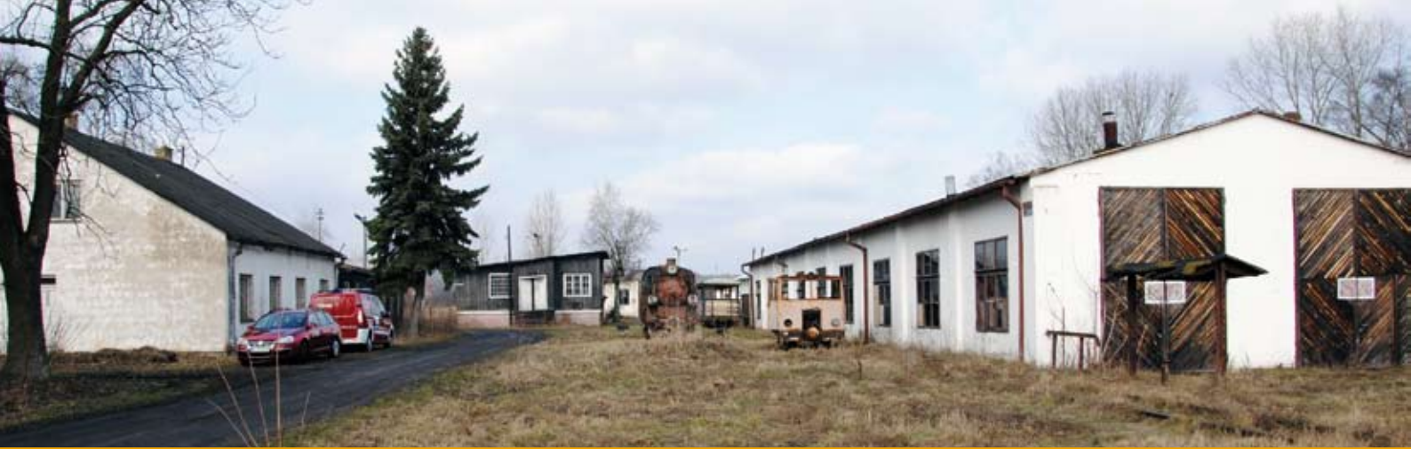
3. Mława, budynek lokomotywowni wąskotorowej, ul. Bracka 9A, Mławska Kolej Dojazdowa, przed 1918, fot. W. Gołębiwska 2019 (ze zbiorów MWKZ)
