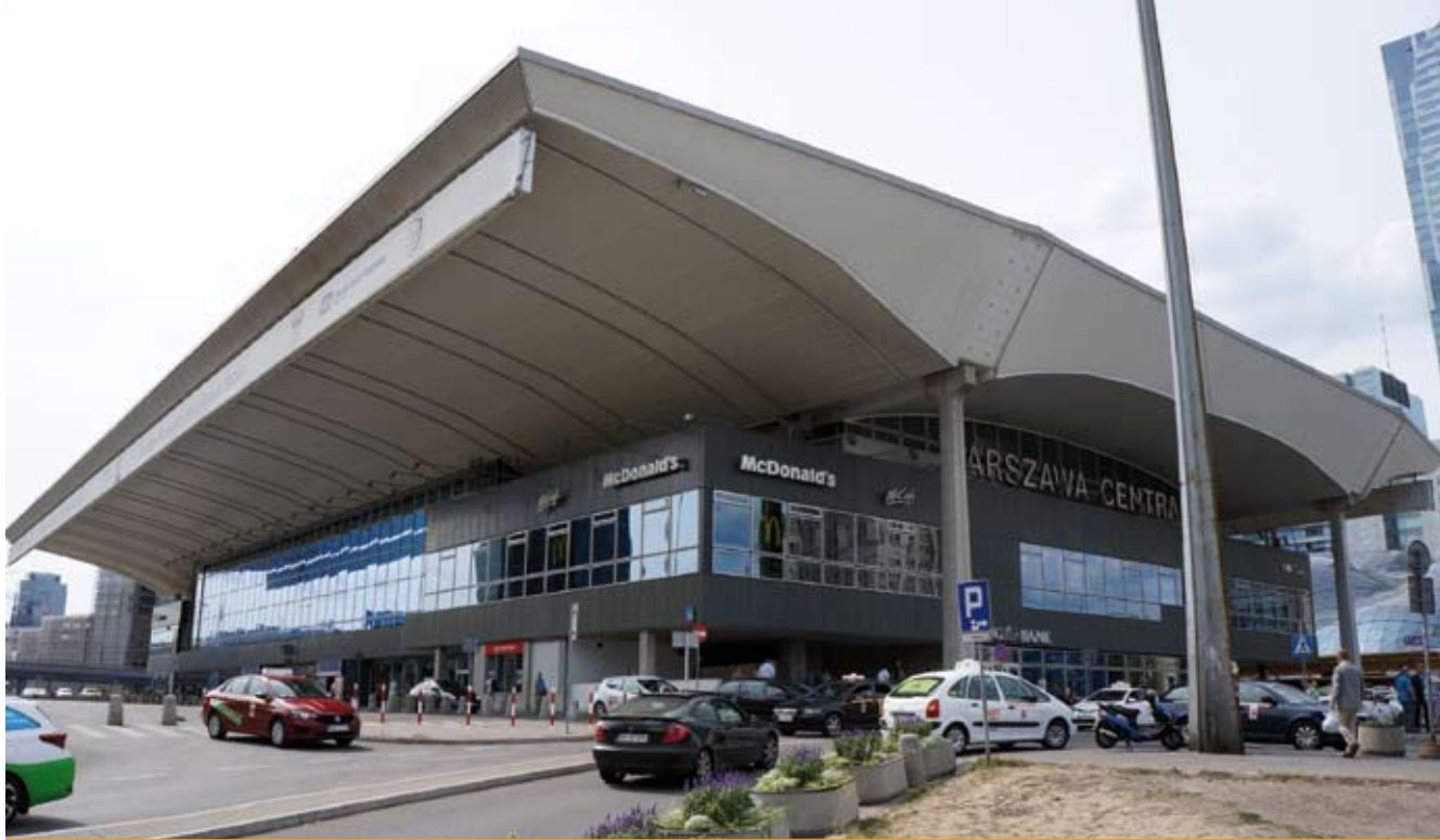
8. Dworzec Centralny w Warszawie, proj. Arseniusz Romanowicz i Piotr Szymaniak, 1972-73 (fot. J. Lewicki 2019)
