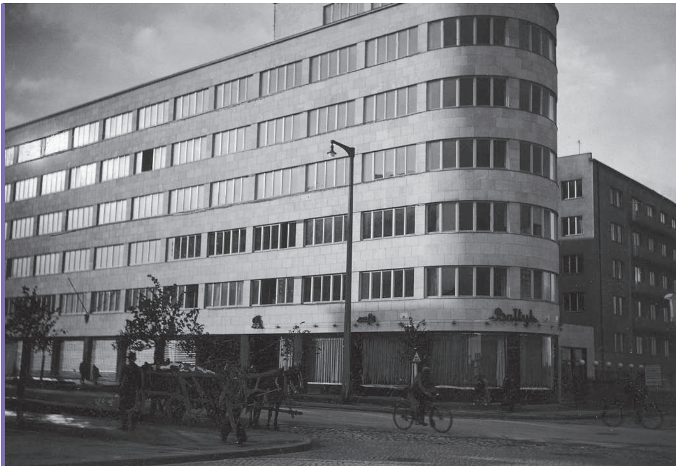
4. Budynek biurowo-mieszkalny Zakładu Ubezpieczeń Społecznych przy ul. 10 Lutego 24 w Gdyni, proj. Roman Piotrowski, 1935–1936; dziś siedziba Urzędu Miasta Gdyni, fot. ze zbiorów Narodowego Archiwum Cyfrowego
