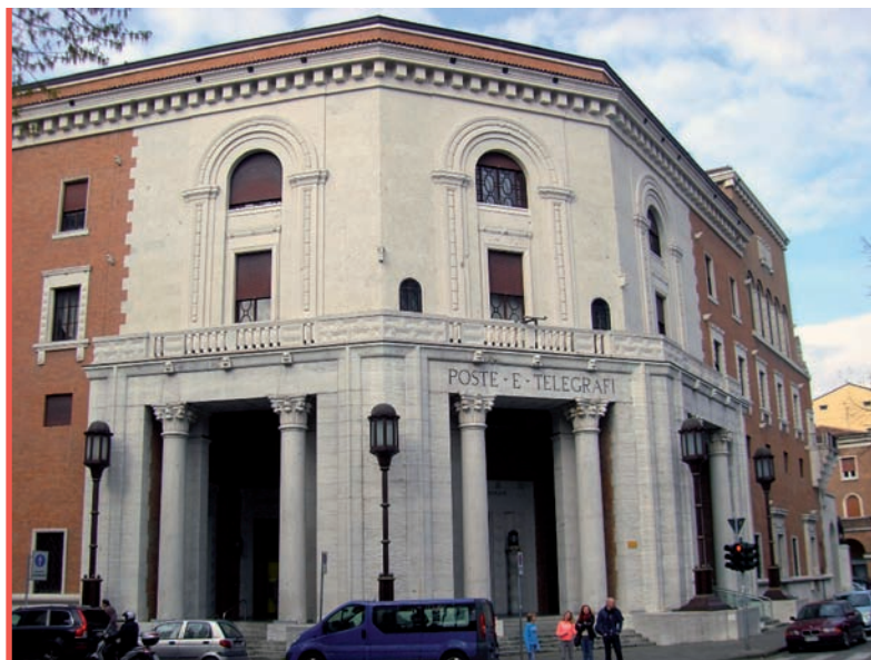
3. Ferrara, Palazzo Postale, Viale Cavour 27, A. Mazzoni, 1930 (fot. B. Ciarkowski)
