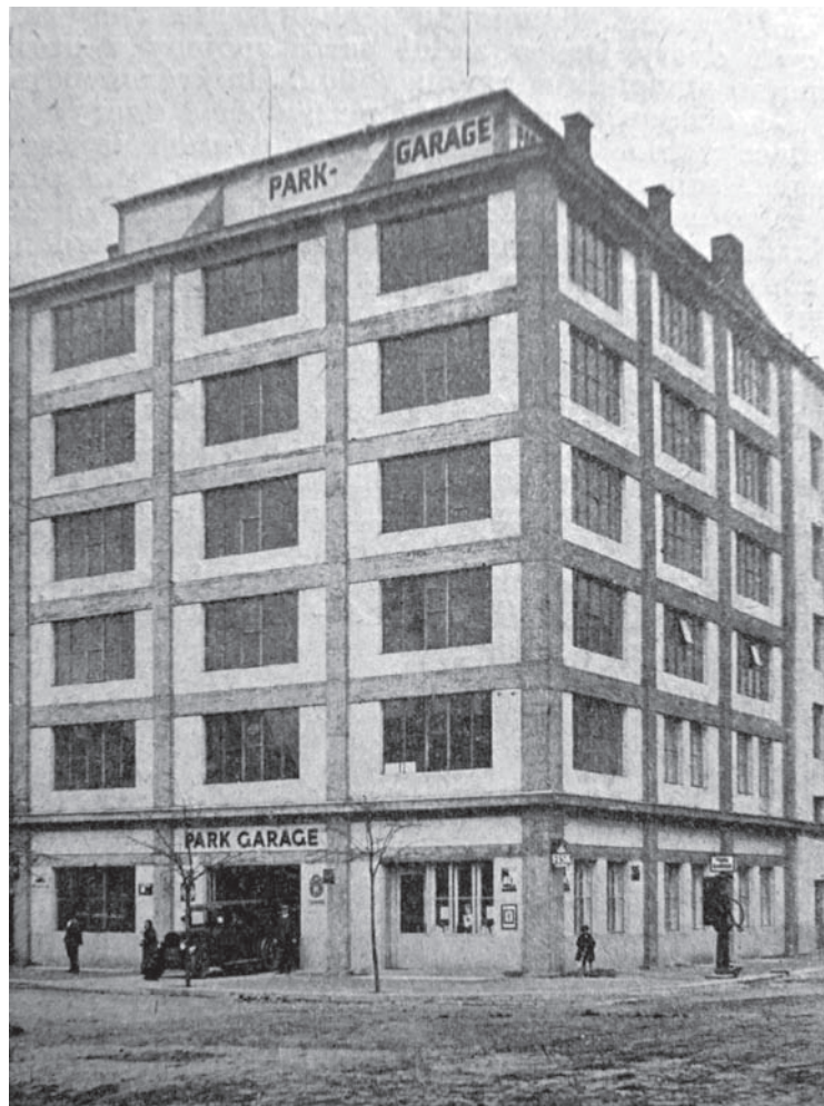
2. Praga, „Park Garage”, ul. Na Maninách 14, architekci Bedřich Adámek i František Čelikovský, 1926 (źródło: Automobilní garáže a sklady , 1929, s. 200)
