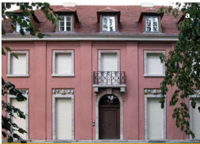
7ab. Poczdnam-Neubabelsberg, Dom Urbiga, proj. Ludwig Mies van der Rohe, 1915-1917, elewacja zachodnia: pozostałości oryginalnego czerwonego "cennego tynku" (Edelputz) z porysowaną powierzchnią pod balkonem nad bramą (fot. photos HAWK/ Hammer, Dannenfeldt, Knappe, Schaack 2006)
