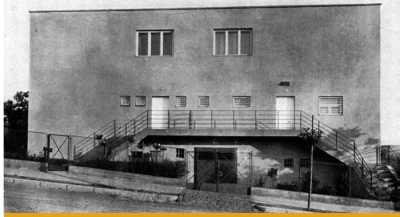
3. Brno, dom bliźniaczy, proj. Otto Eisler, 1926. Nieregularny wygląd powierzchni elewacji wskazuje na zastosowanie porysowanego tynku, prawdopodobnie gotowej mieszanki zaprawy zwanej BRÍZOLIT, z błyszczącymi drobkami miki (Hitchcock-Johnson 1932, s. 133)
