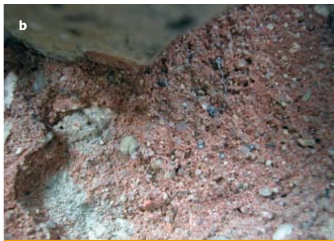
7ab. Poczdnam-Neubabelsberg, Dom Urbiga, proj. Ludwig Mies van der Rohe, 1915-1917, elewacja zachodnia: pozostałości oryginalnego czerwonego "cennego tynku" (Edelputz) z porysowaną powierzchnią pod balkonem nad bramą (fot. photos HAWK/ Hammer, Dannenfeldt, Knappe, Schaack 2006)
