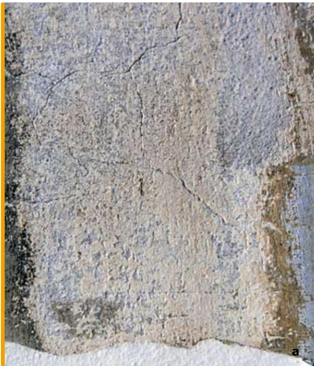
15. Dessau, Bauhaus, Dom-studio, fasada wschodnia: a) detal (czyszczony) 2000. Oryginalna wygładzona powierzchnia z zaprawy wapiennej z naturalnymi pęknięciami skurczowymi. Powierzchnia jest zagęszczana dzięki zastosowaniu i wygładzeniu zawiesiny wapiennej położonej metodą al fresco. Żółty przemyty piasek użyty jako kruszywo w zawieszynie tworzy ogólnie żółtawy odcień i daje nieco ziarnistą powierzchnię (fot. Ivo Hammer 2000); b) próbka tynku z cementem typu dado (wodoodporny). Chropowata, brązowo-piaskowa zaprawa o szarym odcieniu leży na wygładzonej zaprawie wapiennej, która jest wyraźnie zestarzała (fot. Ivo Hammer 2000)
