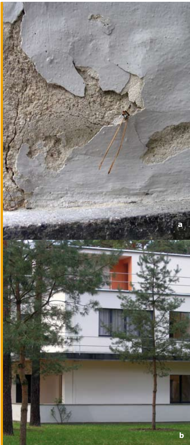
9. Dessau, Bauhaus, domy mistrzów, proj. Walter Gropius, 1925-1926: a) dom mistrza Klee-Kandinsky, fasada, detal. Oryginalny materiał - kolorowa powierzchnia składa się z lekko hydraulicznego tynku wapiennego, który został wygładzony zaprawą wapienną nałożoną techniką al fresco, prawdopodobnie zabarwioną drobnym piaskiem. Pojawia się pod uszkodzeniem niedawno położonej farby (2000), która prawdopodobnie zawiera żywicę syntetyczną i biel tytanową (fot. Ivo Hammer); b) Dom mistrza Muche Schlemmera, fasada odrestaurowana w 2002 r. w wyniku badań konserwatorskich (fot. Ivo Hammer 2006)
