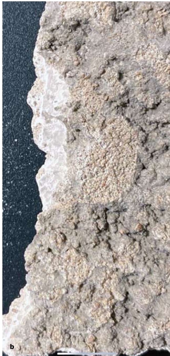
15. Dessau, Bauhaus, Dom-studio, fasada wschodnia: a) detal (czyszczony) 2000. Oryginalna wygładzona powierzchnia z zaprawy wapiennej z naturalnymi pęknięciami skurczowymi. Powierzchnia jest zagęszczana dzięki zastosowaniu i wygładzeniu zawiesiny wapiennej położonej metodą al fresco. Żółty przemyty piasek użyty jako kruszywo w zawieszynie tworzy ogólnie żółtawy odcień i daje nieco ziarnistą powierzchnię (fot. Ivo Hammer 2000); b) próbka tynku z cementem typu dado (wodoodporny). Chropowata, brązowo-piaskowa zaprawa o szarym odcieniu leży na wygładzonej zaprawie wapiennej, która jest wyraźnie zestarzała (fot. Ivo Hammer 2000)
