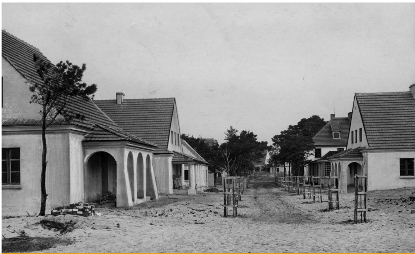
2. Zabudowa nowej osady rybackiej realizowanej przez Państwowy Bank Rolny na Helu. Stan w 1932 r. (źródło: Narodowe Archiwum Cyfrowe NAC, sygn. 1-U-1574-1)
