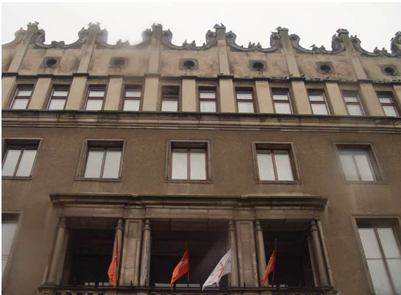
2. „Narodowa forma”, attyka renesansowa, budynek administracyjny Huty (fot. W. Kamiński)
