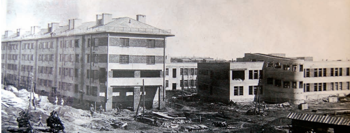
3. Budynek mieszkalny z wyodrębnionymi mieszkaniami dla rodzin w kwartale „Typ 3” w trakcie budowy, projekt Pavel Alyoshin z zespołem, 1930-1932 (źródło: Archiwum Muzeum KhTZ)
