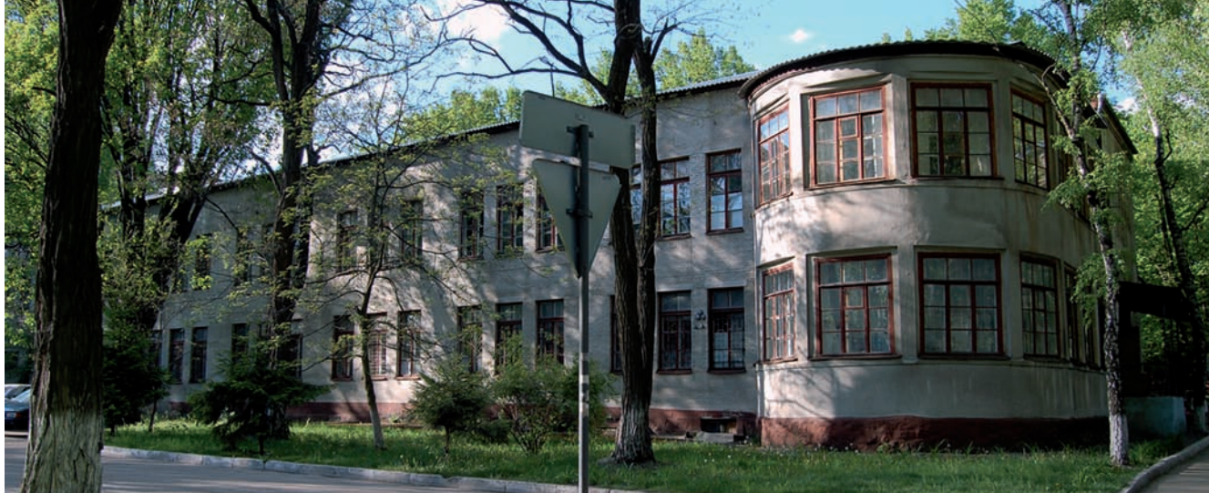
6. Przedszkole i żłobek, proj. N. Manucharova, 1930-1932 (fot. I. Gubkina, 2018)
