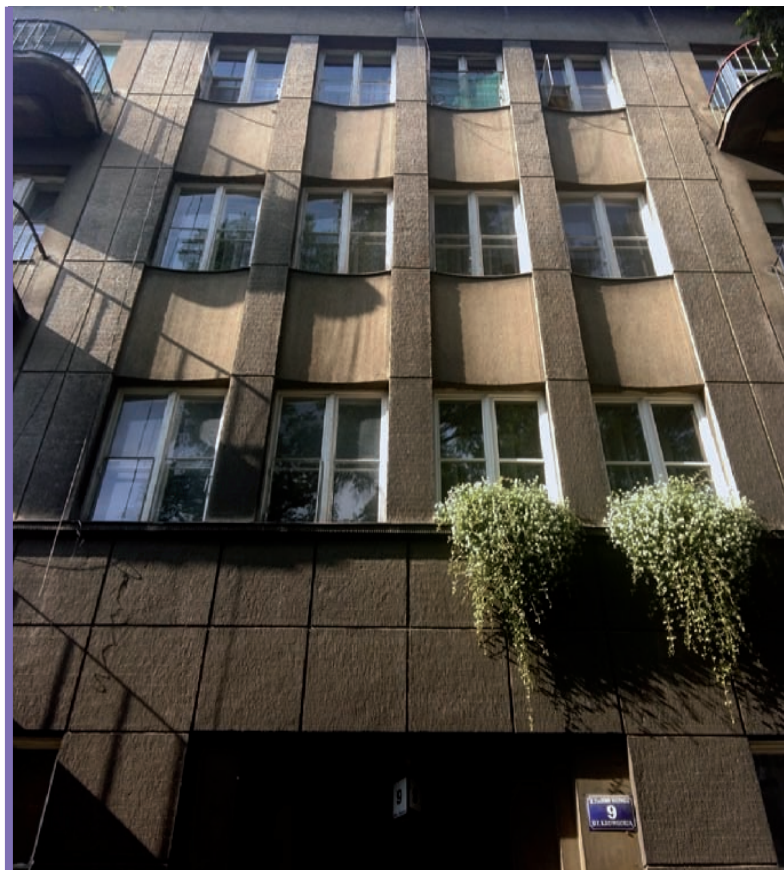
7. Ulica Z. Dunin-Łasowicza. Oryginalne wykończenie elewacji zachowane w bardzo dobrym stanie, boczne światło wydobywa powierzchnie gradzińowane i połyskujące mika tynki gładzone (fot. autorki, 2018)
