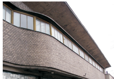
Elewacja boczna sali gimnastycznej - wstęgowe okno doświetlające antresolę sali gimnastycznej
