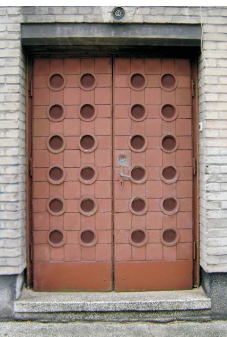
Drzwi wejściowe do sali gimnastycznej - analogiczny wzór został zastosowany w części wysokiej
