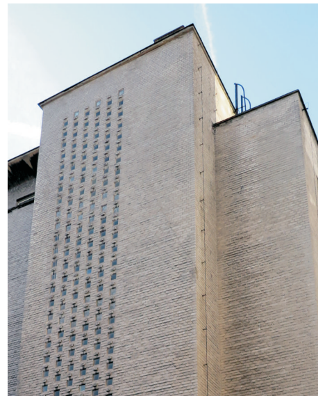
Ryzalit klatki schodowej części wysokiej
