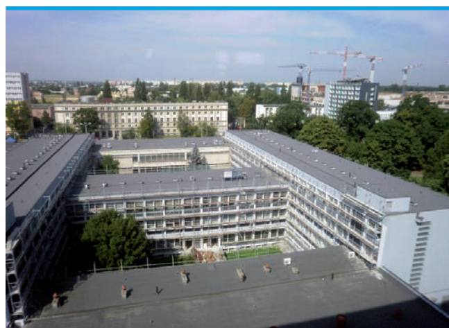
6. Wewnętrzne patia Wydziału Budownictwa, Architektury i Inżynierii Środowiska PŁ w trakcie readaptacji (fot. autorzy, 2014)
