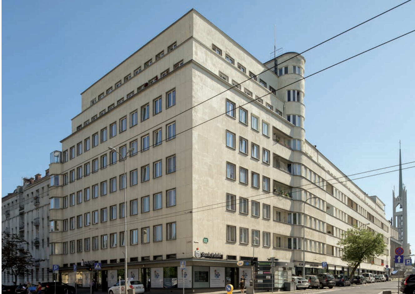
7. Widok zespołu od strony północno-zachodniej (fot. B. Ponikiewski)
