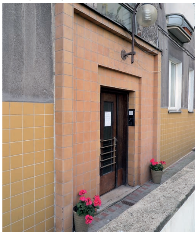
13. Wejście do klatki schodowej skrzydła od ul. Batorego, 2018 r. (fot. autor)
