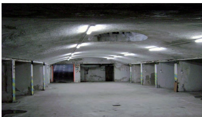
21. Wnętrze garażu podziemnego – widok w stronę wyjazdu na ul. Batorego, 2018 r. (fot. autor)
