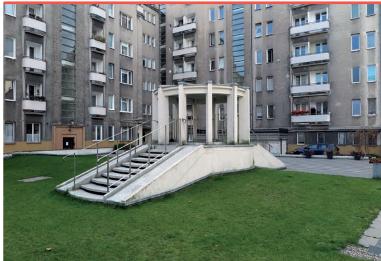
24. Żelbetowa wiata-altana po rewaloryzacji, 2018 r. (fot. autor)
