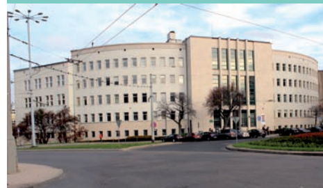
15. Court building, Plac Konstytucji 5
