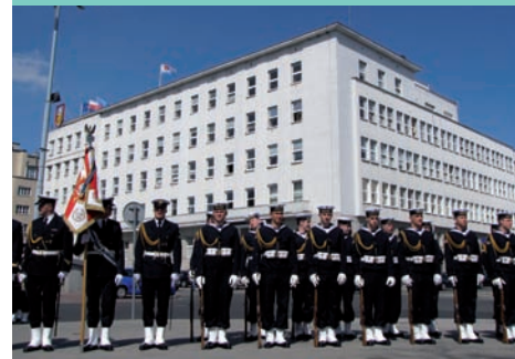
26. Gdynia City Hall, Marszałka Piłsudskiego 52/54 Ave.
