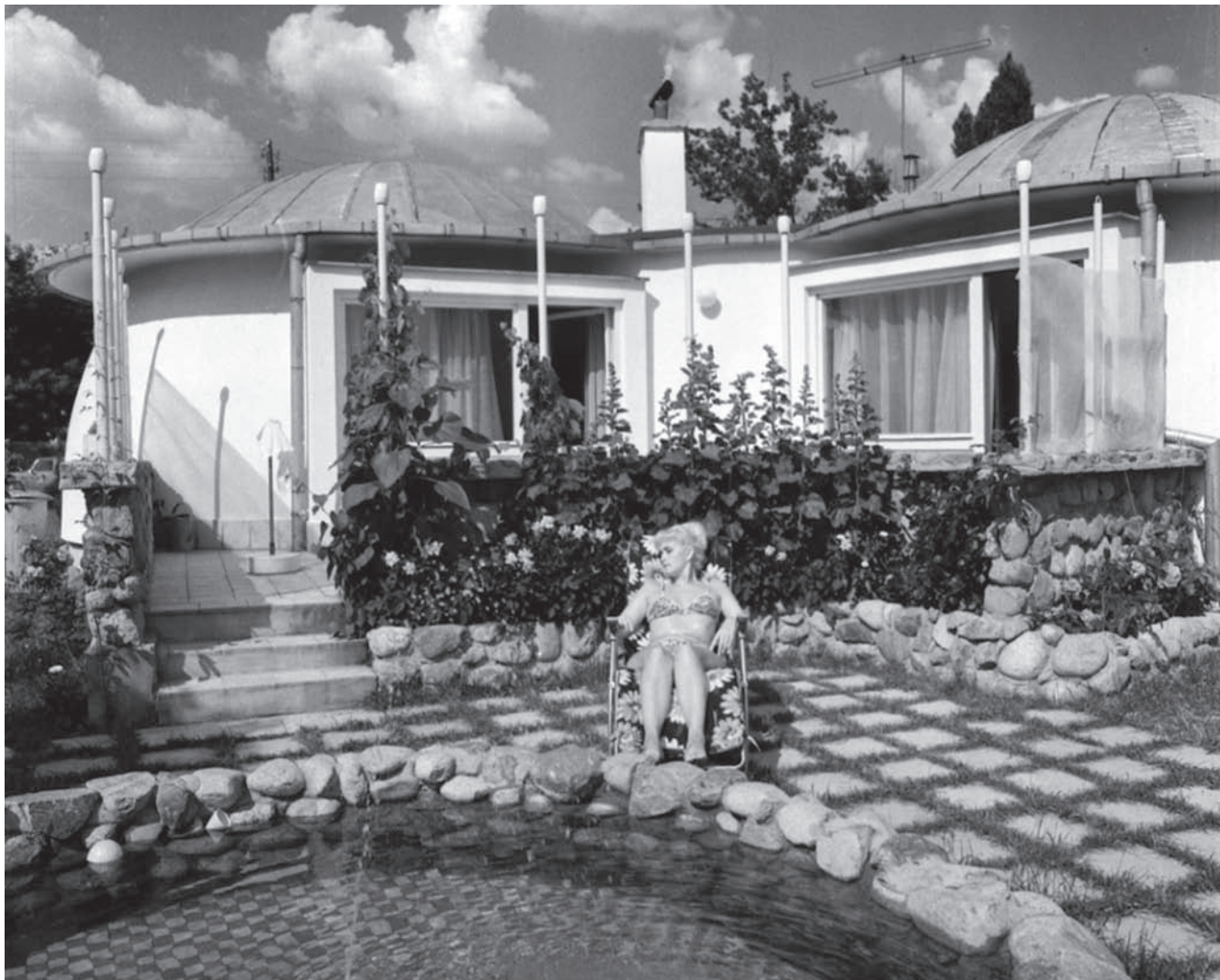
3. Warszawa, osiedle Zakątek, archiwalne zdjęcie domu kopułowego, lata 70. XX wieku (źródło: https://culture.pl/pl/artykul/ufo-wyladowalo-budynki-jak-statki-kosmiczne , fot. Jacek Sielski/Forum)
