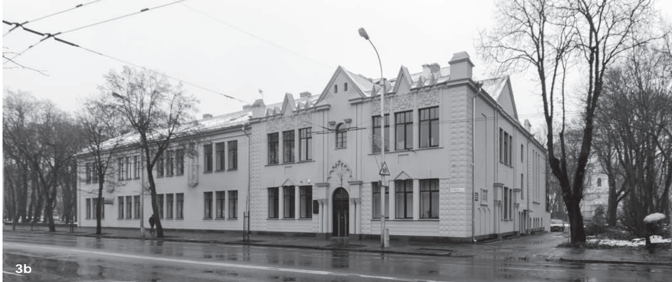
3. Rosyjskie gimnazjum (obecnie Wyższa Szkoła Pedagogiczna) w Kownie (Kaunas), 1925, architekt Aleksandras Gordevičius: a. plan pierwszego piętra (źródło: Baza AUTC, op. cit); b. widok z ulicy (źródło: Kaunas 1918-2015..., op. cit., fot. N. Tukaj, 2014)
