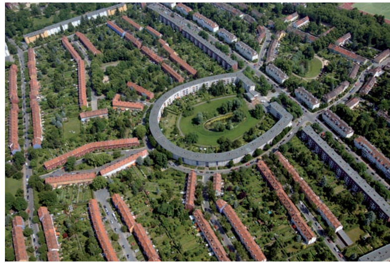
6b. Aerial view (2005) of the large residential area Britz (called Horseshoe development – Hufeisensiedlung) by Bruno Taut. Presse- und Informationsamt des Landes Berlin und Berlin Partner GmbH, GmbH/FTB-Werbefotografie
