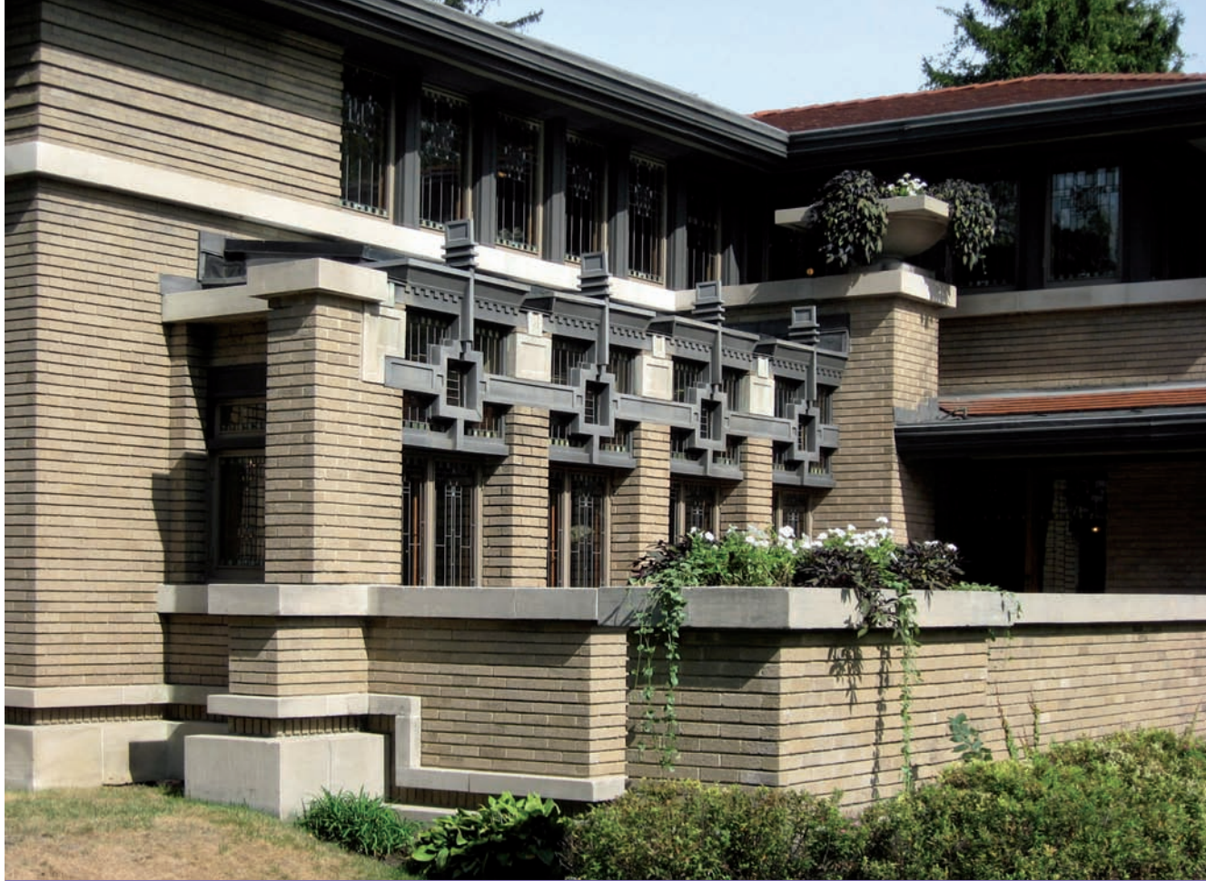
7. Obróbki blacharskie i detale inspirowane nowoczesnym ornamentem Arts & Crafts w zewnętrznym wykończeniu wykusza salonu Meyer May House od południa (fot. M. Czarnecki, 2007)
