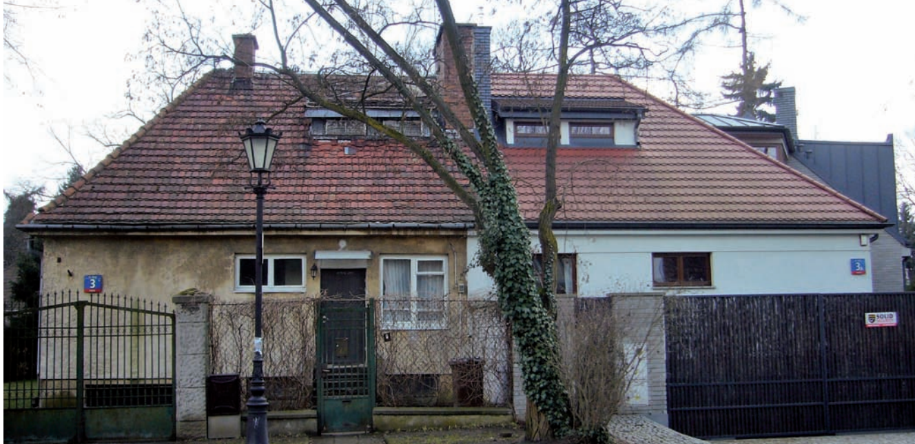
7. Warszawa-Sadyba, dom bliźniaczy przy ul. Zakręt Spółdzielni Budowlano-Mieszkaniowej „Prefabrykacja”, zbudowany z wałków połuszcarskich w latach 1954-1955, proj. M. Mołdawa, 1952-1954, stan w 2018 (fot. M. Rozbicka)
