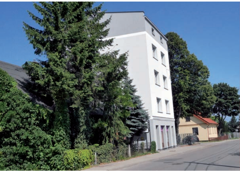
12. Wysokie kamienice zbudowane w latach 30. XX wieku pomiędzy wiejskimi domami dawnego siedliska Oksywia (fot. M. J. Sołtysik, 2018)
