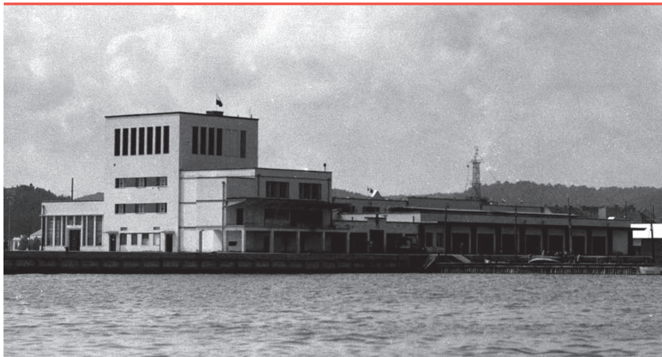
8. Gdynia, Chłodnia i Hala Rybna (od lewej: hala maszyn, mieszkania pracownicze z pomieszczeniami skraplaczy na szczycie, przy nabrzeżu skład lodu wraz z „fabryką lodu”, a wzdłuż niego - chłodnia właściwa i Hala Rybna), inż. Juliusz Mrozowski, 1930 r. (zbiory Narodowego Archiwum Cyfrowego w Warszawie)
