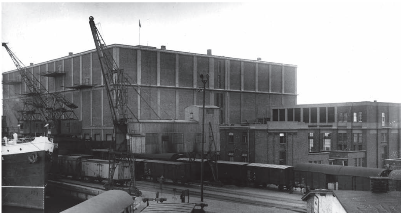
2. Gdynia, Chłdnia Portowa, proj. technologiczny Ateliers „Bruno Lebrun”, I etap - 1929-1930, II etap - 1933-1934 (fot. „Foto-Elite” dla Koncernu Ilustrowanego Kuriera Codziennego, zbiory Narodowego Archiwum Cyfrowego w Warszawie)
