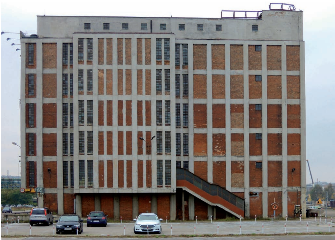
11. Gdynia, Chłodnia Nr 2 (przed rozbudową o nazwie - Chłodnia Śledziowa), proj. Towarzystwo Robót Kolejowych i Budowlanych TOR z Warszawy, I etap - 1935-1936, II etap - 1960-1965, stan z 2016 r. (fot. A. Orchowska-Smolińska)
