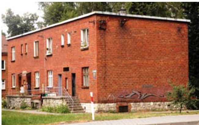
10. Chełmek, ośmiorodzinne domy dla pracowników (fot. A. Syska, 2007)
