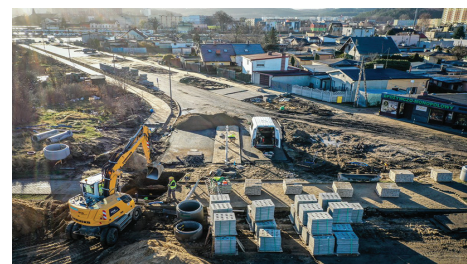
Prace rewitalizacyjne na osiedlu Meksyk // fot. Karolina Misztal-Swidarska
