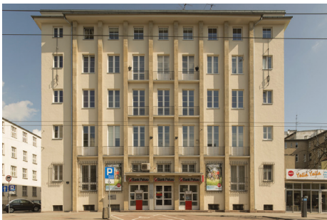
Budynek BGK ul.10 Lutego 8/Zygmunta Augusta 13, prace konserwatorskie przy elewacjach prowadzono w latach 2013-2019./fot. B. Ponikiewski
