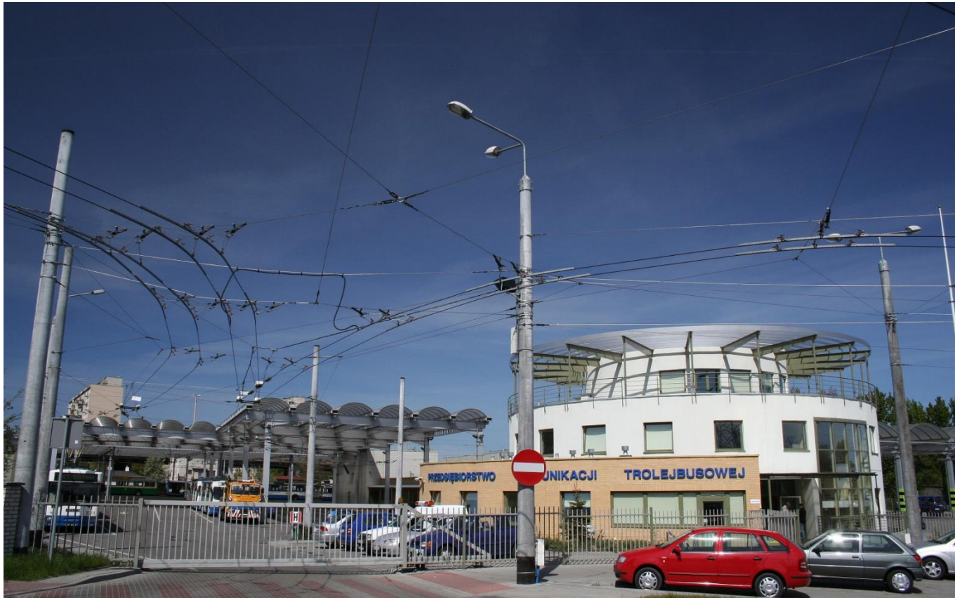
Fot. Nowa zajezdnia trolejbusowa przy ul. Zakręt do Oksywia w Gdyni. Materiały ZKM w Gdyni
