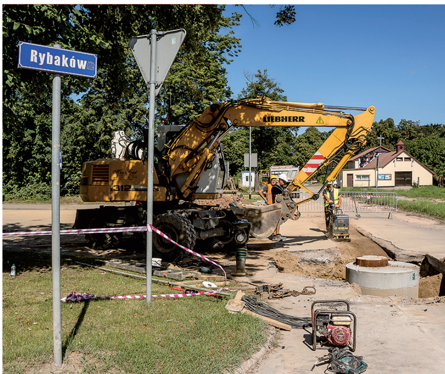
Przy ulicy Rybaków zakończyła się już budowa blisko dwukilometrowej sieci kanalizacji
