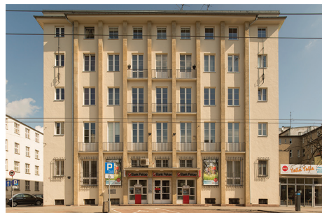
↑Bank Gospodarstwa Krajowego przy ul. 10 Lutego 10, masywne lizeny wykonane z bloków żółtoszarego wapienia, pozostałe partie elewacji wykończone tynkiem.
