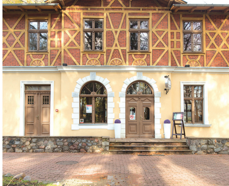
Elewacja d. Zajazdu Adlera (ob. Liceum Sztuk Plastycznych), przy ul. Orłowskiej 8 , przełom XIX i XX w., parter murowany, piętro w konstrukcji ryglowej z ozdobnym zwieńczeniem szczytu ryzalitu
