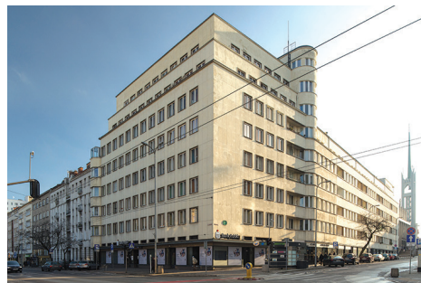
Budynek przy ul. 3 Maja 27-31 , lata 30. XX w., elewacje powyżej parteru wykończone okładziną z płyt kamiennych z wapienia pińczowskiego
