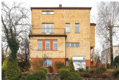
Budynek przy ul. Inżynierskiej 111 , lata 30. XX., elewacja oblicowana żółtymi płytkami ceramicznymi
