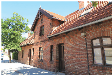
Ceglana elewacja budynku przy ul. Św. Mikołaja 9 , pocz. XX w.
