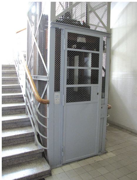
Winda w kamienicy przy ul. Świętojańskiej 53, wejście
