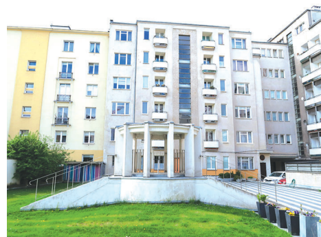
Żelbetowa, naziemna wiatra garażu podziemnego, mieszcząca doświetlenie i wentylację wnętrza, w budynku przy ul. 3 Maja 27-31
