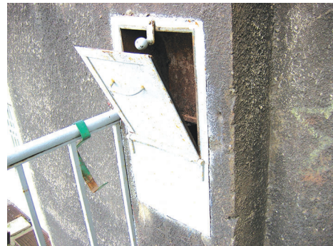
Zbiorczy zsyp na śmieci z włotem na balkonie w kamienicy przy ul. Abrahama
