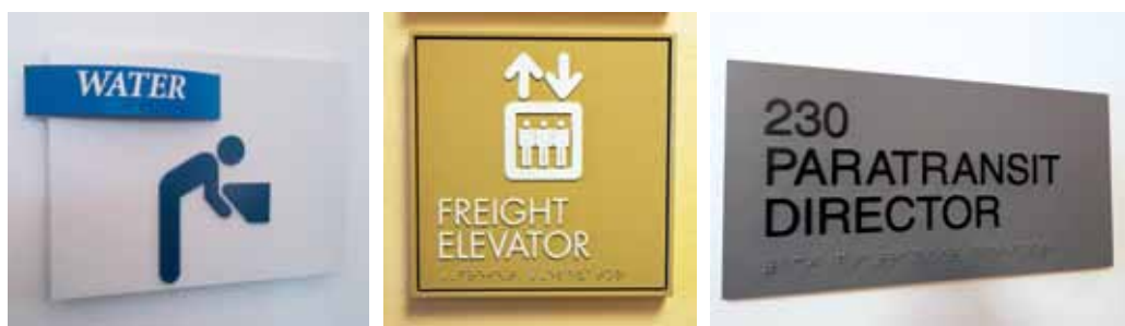
Ryc. 8. Przykłady informacji opartej na czytelnych piktogramach oraz informacji tekstowej w druku wypukłym i opisanej pismem Braille'a (zdj. M. Wysocki).
