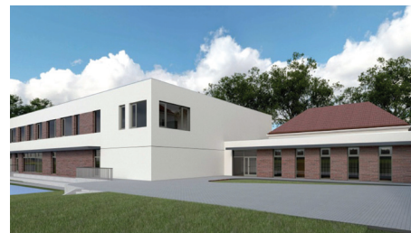
Budowa hali przy SP nr 20 // fot. wizualizacja SWZ
