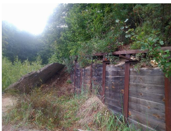
Fot. nr 184, 185. Fragmenty muru oporowego na terenie po byłych basenach, od strony lasu
