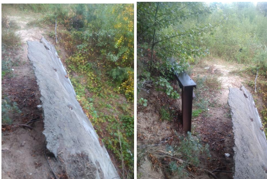
Fot. nr 182, 183. Metalowe i betonowe pozostałości po byłych basenach
