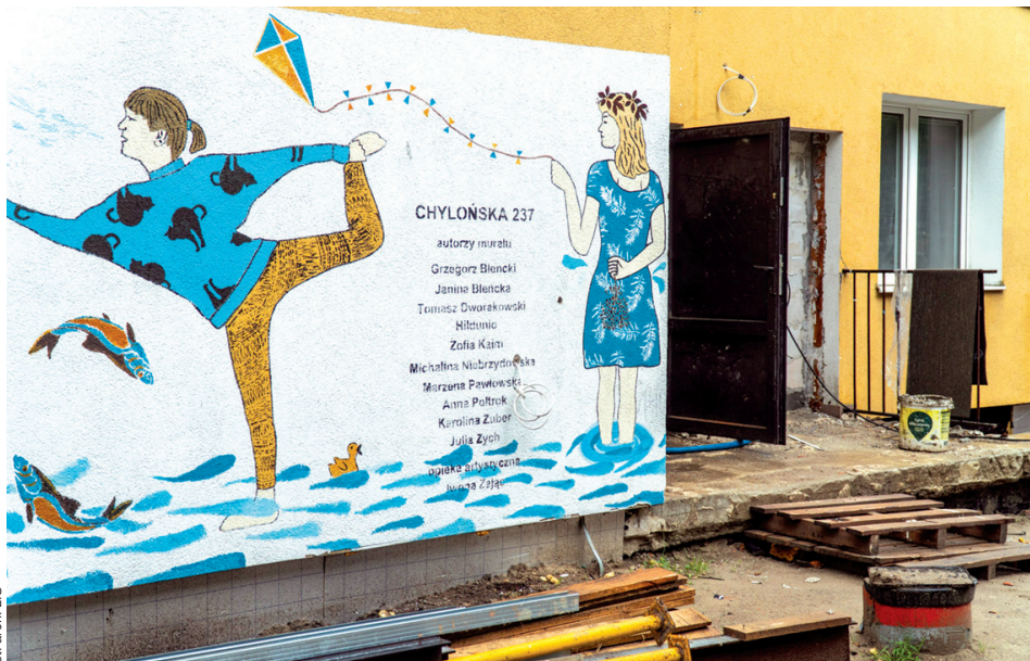
Przystań Chyłońska 237 powstaje w budynku dawnego Zespołu Szkół Ekologicznych
