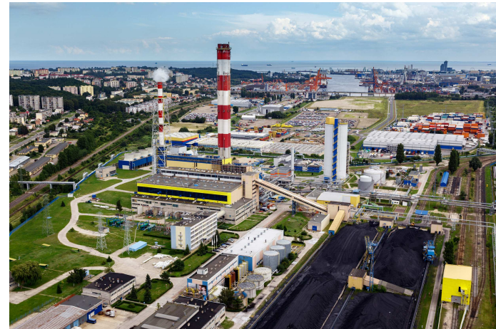
Elektrociepłownia Gdańska – jedyny dostawca ciepła na potrzeby miejskiej sieci ciepłowniczej w Gdańsku i Sopocie
