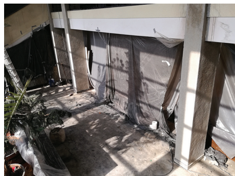
Hol w trakcie prac restauratorskich w 2020 r.
