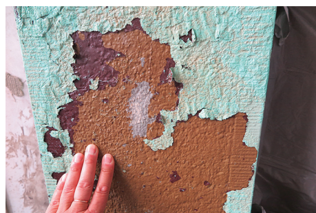
Warstwy farby na filarze w trakcie usuwania w celu odsłonięcia oryginalnego wykończenia z szarej wyprawy imitującej kamień.
