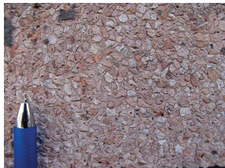
Tynk w kolorze różowym z ziarnami białego i różowego żwirku (w powiększeniu), na elewacji budynku przy ul. Bema.
