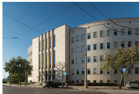
Gmach sądu obecnie – widok od strony południowej.
