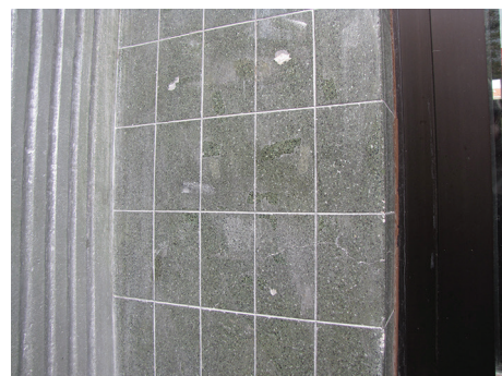
Tynk w kolorze zielonym szlifowany i polerowany z nacięciami imitującymi spoiny płytek, na kamienicy przy ul. Starowiejskiej.
