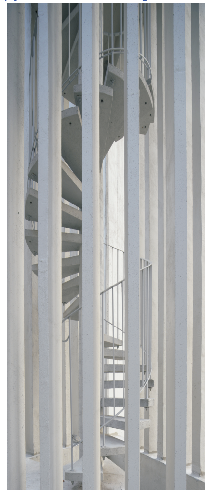
Ażurowe schody zlokalizowane wewnątrz wolnostojącej wieży dzwonnej z 1981 r.
