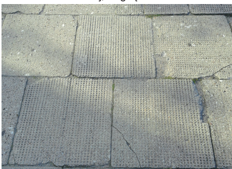
Nawierzchnia chodnika z płyt betonowych o wymiarach 50x50 cm z charakterystycznymi wgłębieniami stosowanymi w latach 30. XX w.
