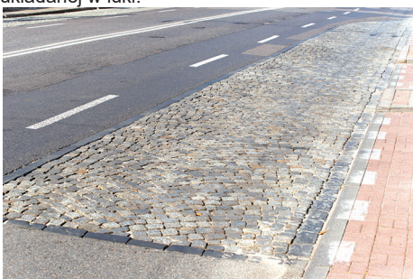
Brukowana pasma boczne ulicy 10 Lutego wykonane w okresie międzywojennym, aby nie niszczyć nawierzchni asfaltowej, biegnące środkiem.
