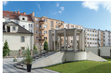
Żelbetowa wiata-altana na podwórzu budynku przy ul. 3 Maja 27-31, doświetlająca i wentylująca garaż podziemny, unikatowa w skali ogólnopolskiej, która nie została wykończona z uwagi na wybuch wojny i została dopiero odrestaurowana i wykończona w 2015 r. ze środków gminy.
