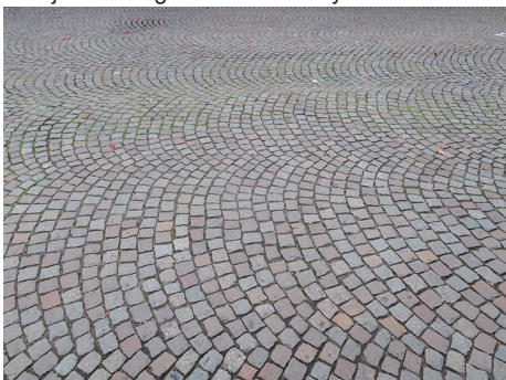
Brukowa nawierzchnia z małej kostki kamiennej układanej w łuki.
