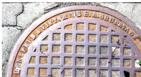
Żeliwna pokrywa studzienki kanalizacyjnej z firmy „Herzfeld i Victorius” z Grudziądza, występująca w wielu miejscach miasta.
