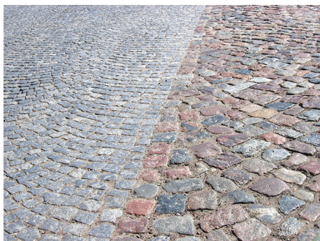
Dwa rodzaje nawierzchni brukowej z regularnej kostki i grubnie obrobionych kamieni.
