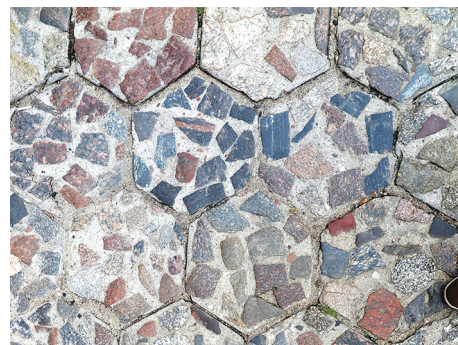
Betonowa kostka sześciokątna tzw. trylińska (od nazwiska Tryliński), z powierzchnią wyłożoną naturalnymi kamieniami, stosowana w latach 30. XX w. i po wojnie.
