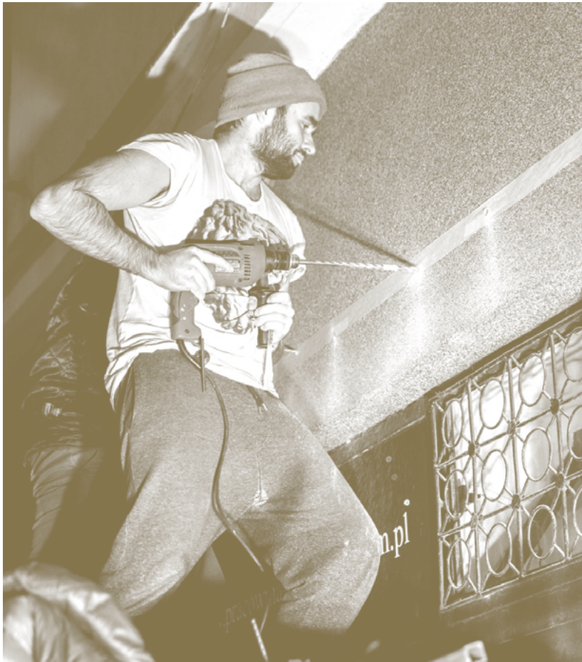
↑ Fot. 17. Montaż szyldu.
