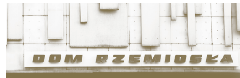
↑ Fot. 5. Szyld „Domu Rzemiosła” – litera przestrzenna montowana na podkładzie z efektem halo.
