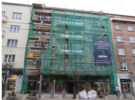
Budynek w trakcie prac w 2020 r.
