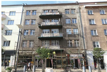
Elewacja frontowa budynku przed konserwacją.
