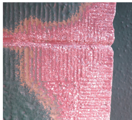
Szczegół wykończenia portalu z wykutymi dętymi gęstymi rowkami.
