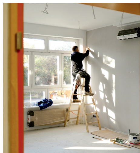
Przy ul. Śmidowicza 49 trwają ostatnie prace wykończeniowe
