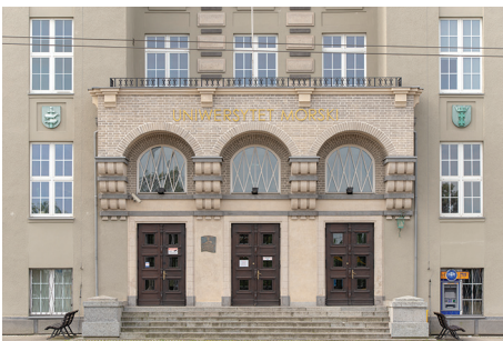
Część wejściowa do głównego budynku Uniwersytetu Morskiego z lat 20. XX w. na Grabówku, podkreślona trzema arkadami z balkonem na konsolach. Po lewej stronie przed pracami restauratorskimi, po prawej po konserwacji w 2015 r. i odslonięciu historycznego wykończenia.
