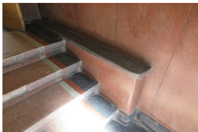
↑ Fragment strefy wejściowej w kamienicy przy ul. Bema 15, dolne partie ścian oraz posadzka wykonana z lastryka o intensywnych kolorach.
