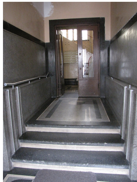
Strefa wejściowa w kamienicy przy ul. Świętojańskiej 122, dolne partie ścian oraz posadzka wykonana z lastryka, po obu stronach także dekoracyjne, aluminiowe poręcze.
