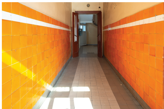
Strefa wejściowa w kamienicy przy skwerze Kościuszki 14, dolne partie ścian wykończone ceramicznymi pomarańczowymi płytkami z wykończeniem z białym paskiem.
