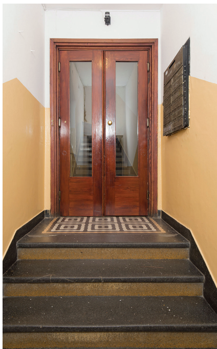
Strefa wejściowa w czynszowym domu wielorodzinnym przy ul. Słupskiej 9, posadzka wykonana z lastryka, przed drzwiami kompozycja z gorsecików, na ścianie historyczna skrzynka na listy.
