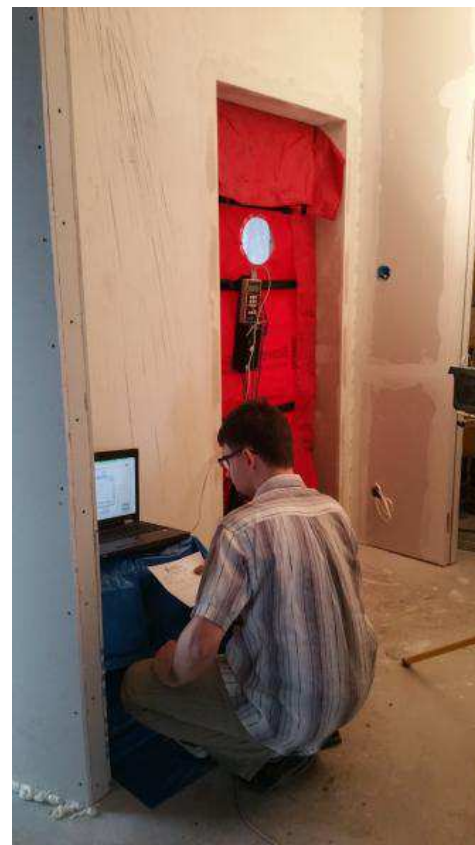
Blower door test – test szczelności
