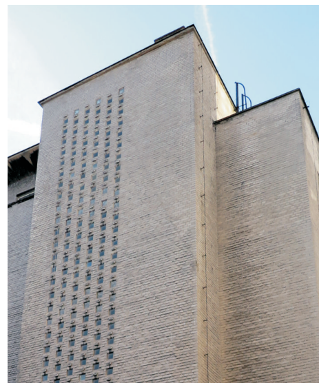
Ryzalit klatki schodowej części wysokiej
