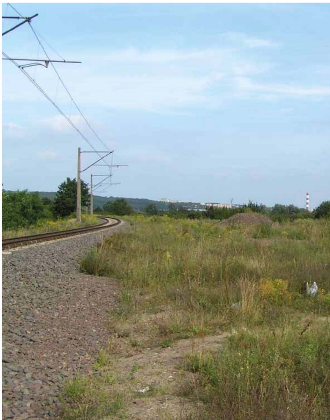
Ryc. 15. Przytorze / Fig. 15. Railway trackside
