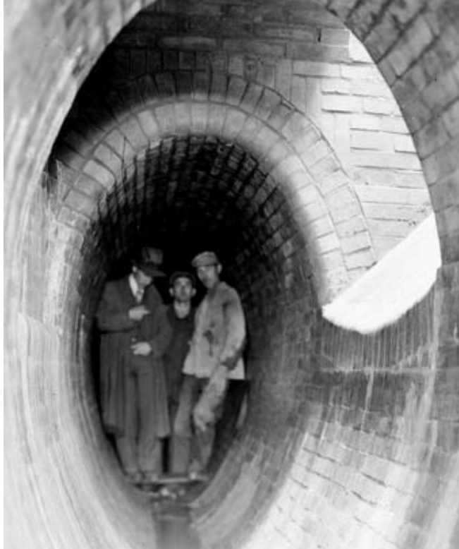
1. Fotografia z okresu budowy łódzkich kanałów (źródło: archiwum Wojewódzkiego Urzędu Ochrony Zabytków w Łodzi)
