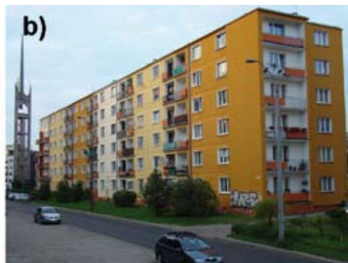
3. Wielorodzinny budynek mieszkalny przy ulicy 3 Maja 37 wykonany z tynkowanych w zakładzie prefabrykacji prefabrykatów wielkoblokowych w układzie pasmowym: a) widok w okresie realizacji, b) stan istniejący
