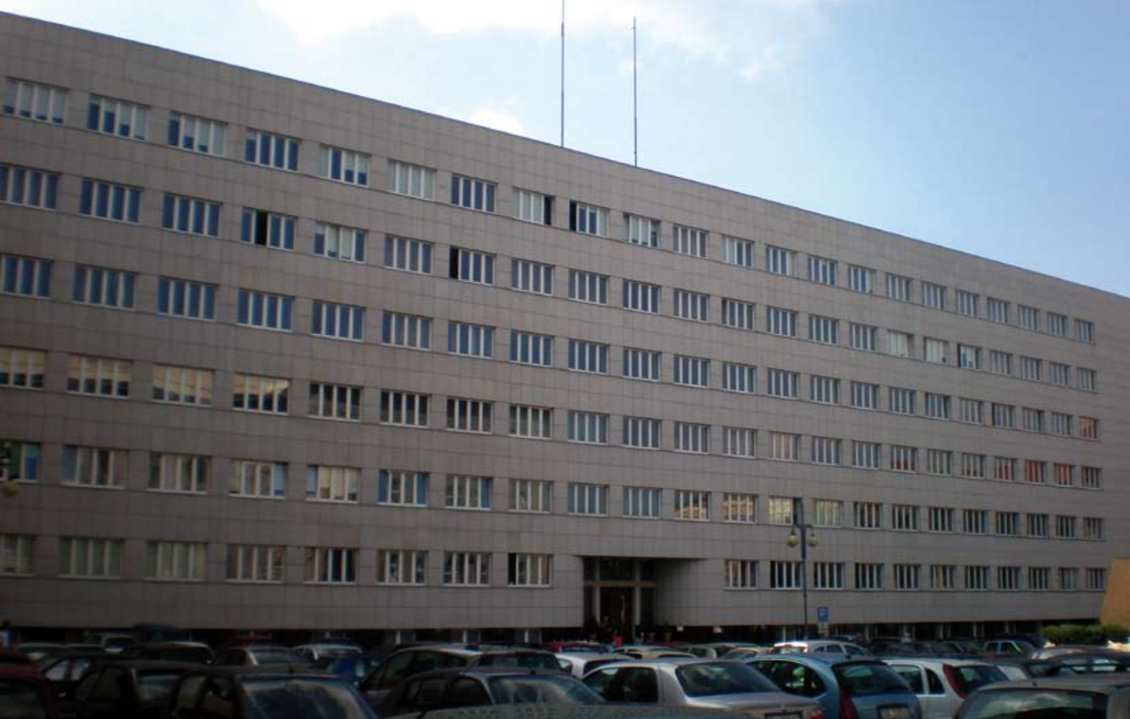
5. Budynek d. gmachu Urzędów Niezespólonych w Katowicach, pl. Sejmu Śląskiego, proj. W. Klębkowski 1935-36 r. Stan po remoncie, docieplenie z wymianą okładziny kamiennej. Fot. B. Klajmon, sierpień 2009 r.
