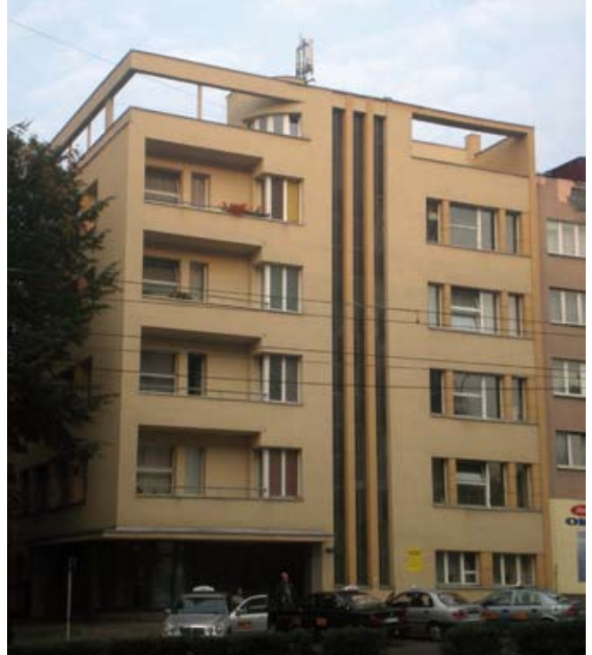
6. Budynek mieszkalny Al. W. Korfantego 60 w Katowicach, proj. K. Schayer, 1937 r. Stan po remoncie – docieplenie elewacji z zastosowaniem tynków cienkowarstwowych. Fot. B. Klajmon, sierpień 2009 r.
