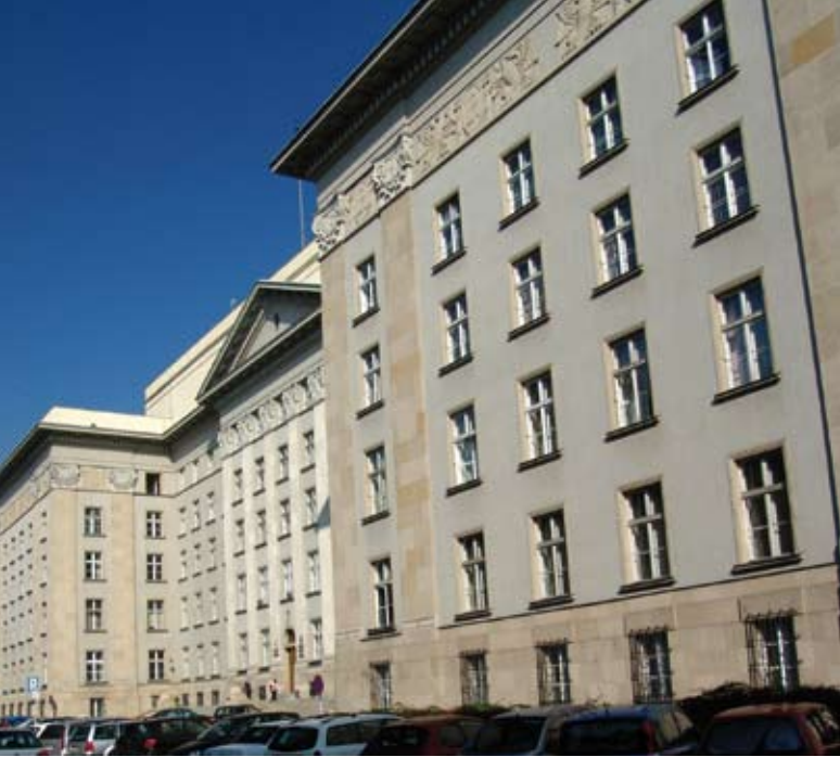
1. Budynek Śląskiego Urzędu Wojewódzkiego w Katowicach, ul. Jagiellońska nr 25, proj. K. Wyczyński, L. Wojtyczko, S. Żeleński, 1923-1929, stan po konserwacji. Fot. Barbara Klajmon, sierpień 2009 r.
