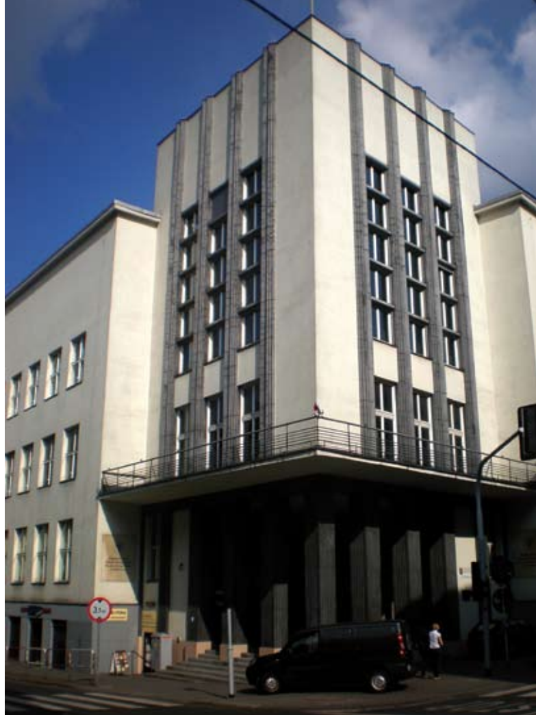
2. Budynek d. Towarzystwa Oświatowego w Katowicach, ul. Francuska 12, proj. S. Tabeński, 1928 r., stan po konserwacji. Fot. B. Klajmon, sierpień 2009 r.
