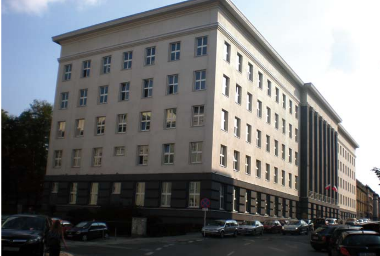
4. Budynek d. Syndykatu Polskich Hut Żelaza, ul. Lompy 14 w Katowicach, proj. T. Michejda, L. Sikorski, 1928 r. Stan po konserwacji, wymiana tynków na tynki podobne lecz wykonane we współczesnej technologii. Fot. B. Klajmon, sierpień 2009 r.
